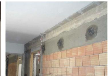
2. Depolverizzazione delle superfici di intaglio e lavaggio con acqua a bassa pressione in guisa di avere le superfici umide prima dell'esecuzione delle fasi successive.
