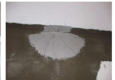
7. Applicazione di un secondo strato di malta cementizia a reattività pozzolanica bicomponente per uno spessore di circa 6 mm sulla intera superficie sulla quale è stata applicata la rete in fibra di vetro. Nell'applicare la malta si avrà cura di lasciare a vista una superficie di rete di dimensioni 10x10 cm intorno a ciascuno dei fori realizzati precedentemente (vedi schema di Figura 5)
