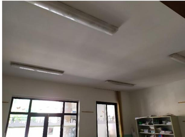
L'illuminazione del piano terra, di più recente realizzazione, è realizzata mediante plafoniere con lampade fluorescenti lineari tipo 2x36W/2x58W installate a plafone.
