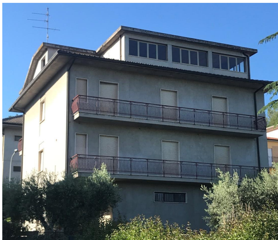
Foto 4: fronte Sud, in evidenza gli infissi al piano terzo sottotetto
