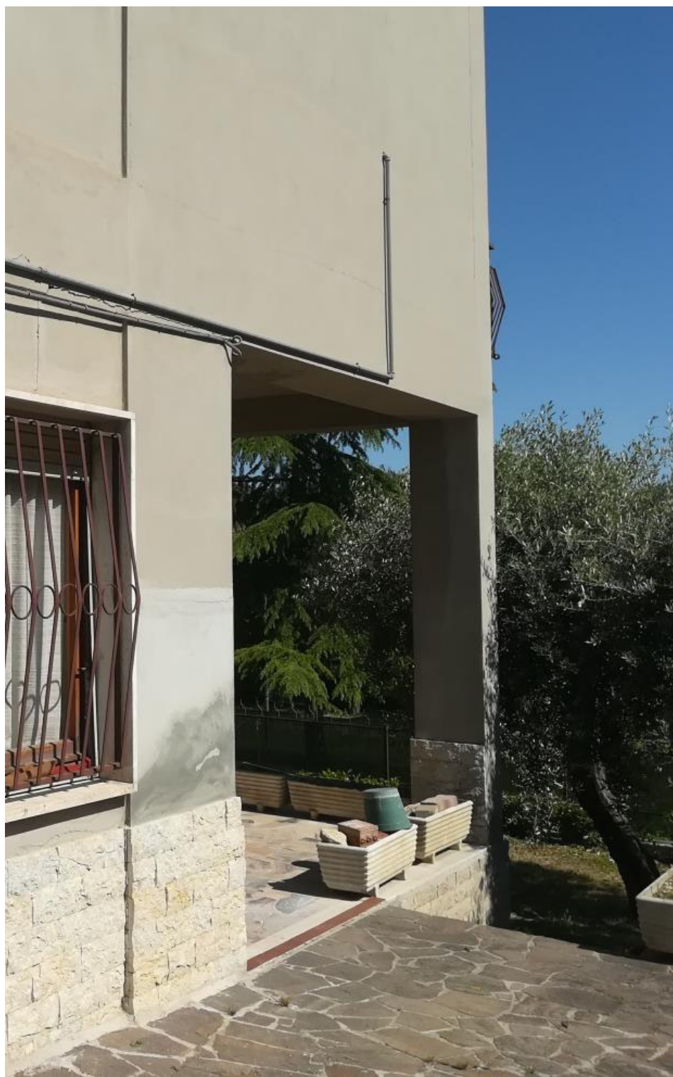
Foto 10: fronte Ovest, piano terra, loggia
