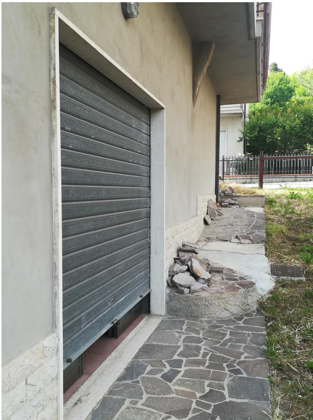
Foto 15: fronte Est, accesso alla Sub. 8
