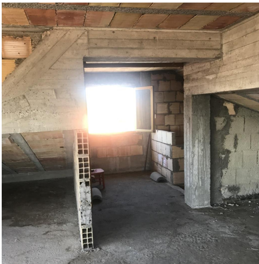
Foto 41: in evidenza la finestra sul fronte Ovest
