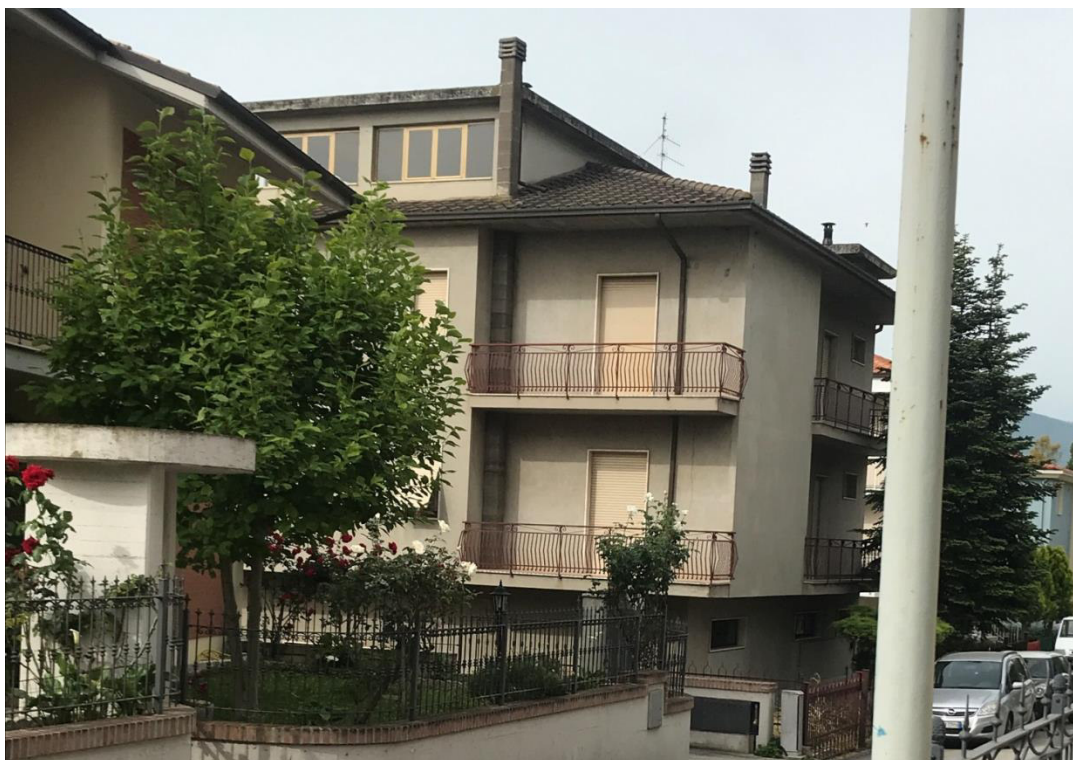
Foto 3: fronte Est, in evidenza la diversa posizione delle finestre dei bagni e gli infissi al piano terzo sottotetto
