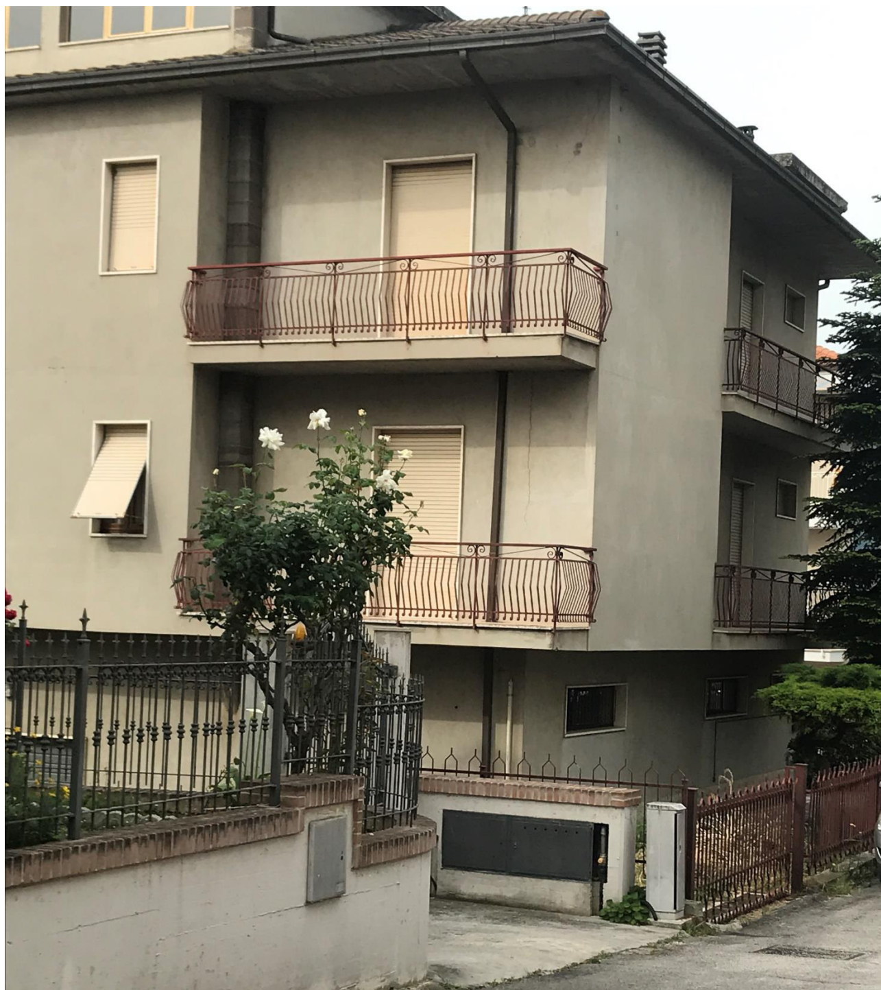
Foto 8: fronte Nord – Est, in evidenza l'accesso da cancello metallico scorrevole
