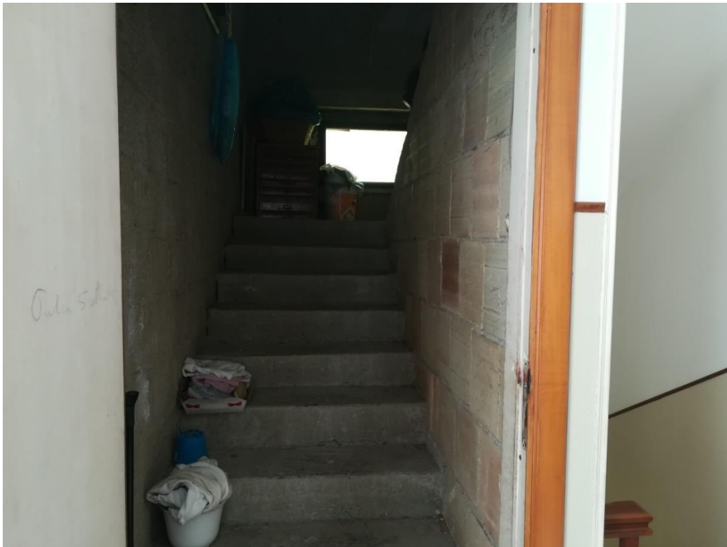
Foto 32: ingresso al piano secondo in F3
