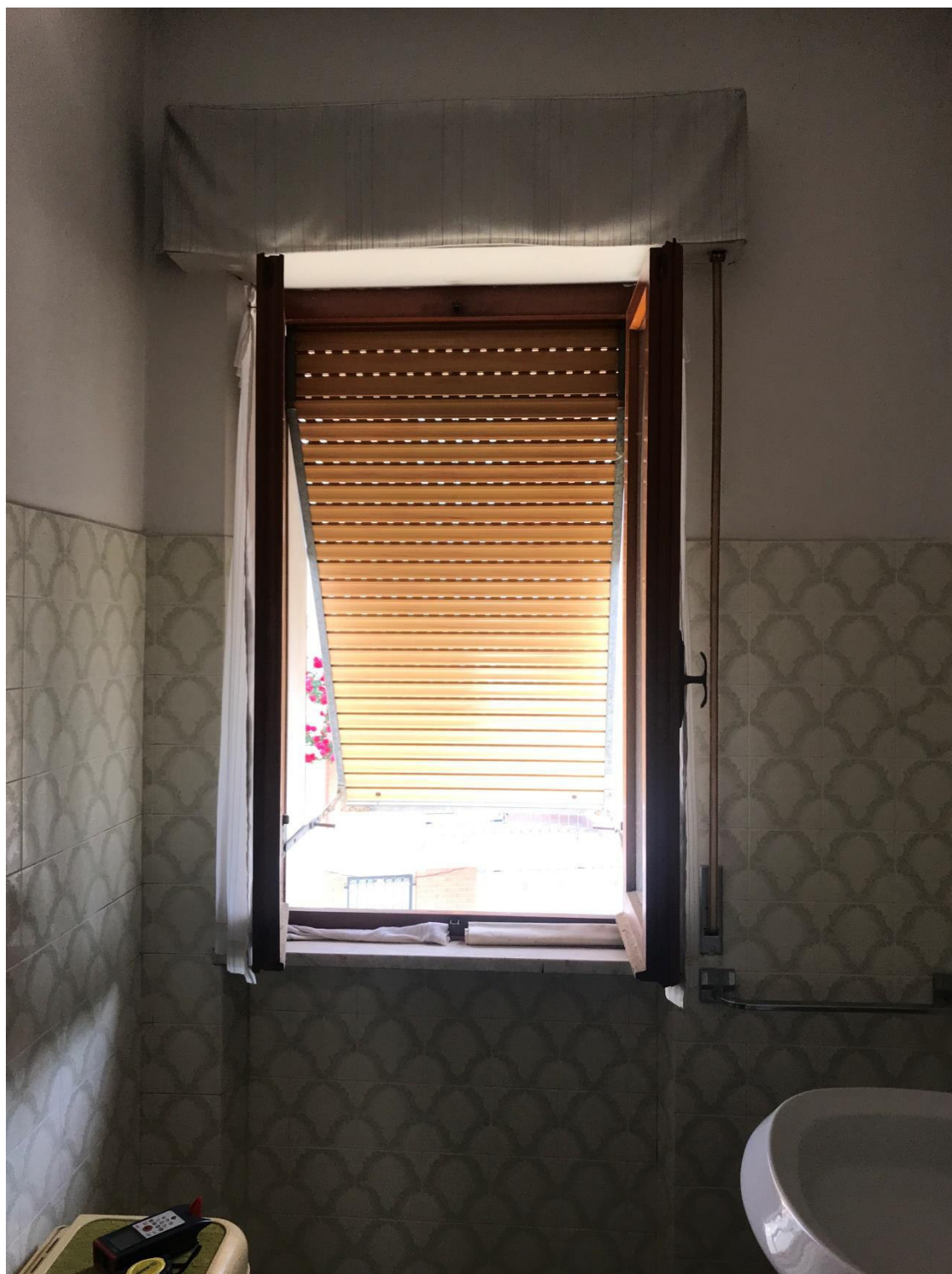
Foto 30: in evidenza la posizione della finestra sul fronte Est
