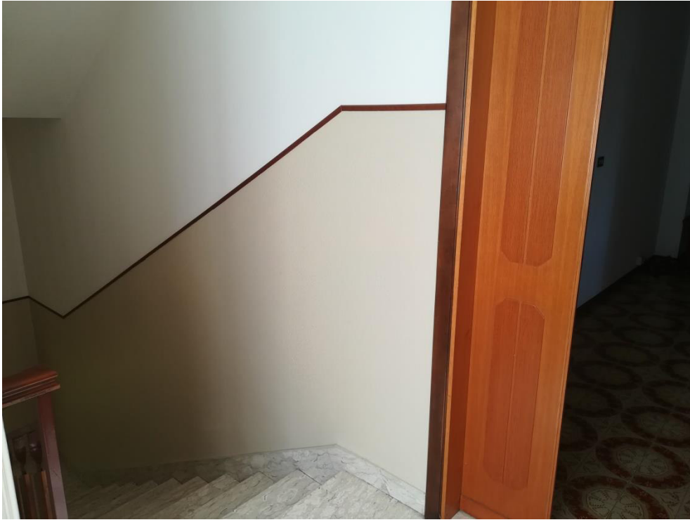
Foto 22: piano primo, ingresso alla Sub. 7
