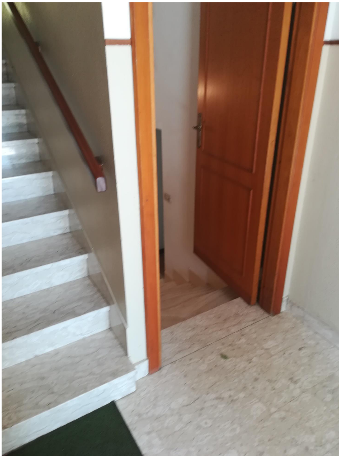
Foto 13: piano terra, ingresso comune
