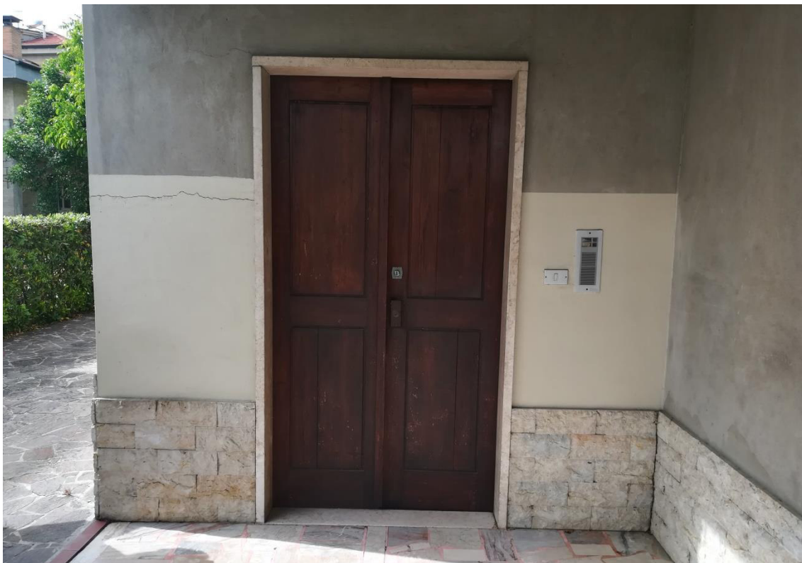
Foto 11: fronte Sud, piano terra, ingresso dalla loggia
