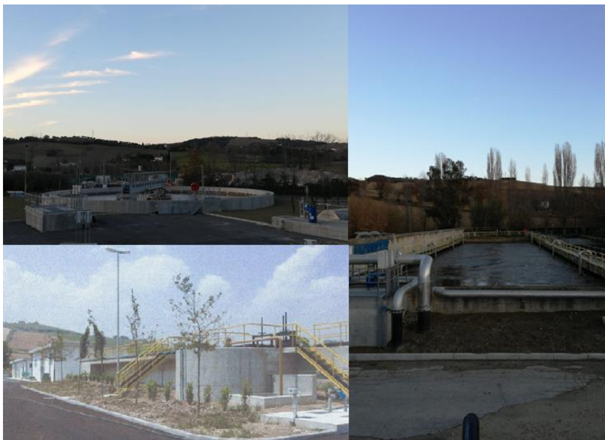
Figura 9 - Impianto depurazione Salvano- Realizzazione nuova vasca
