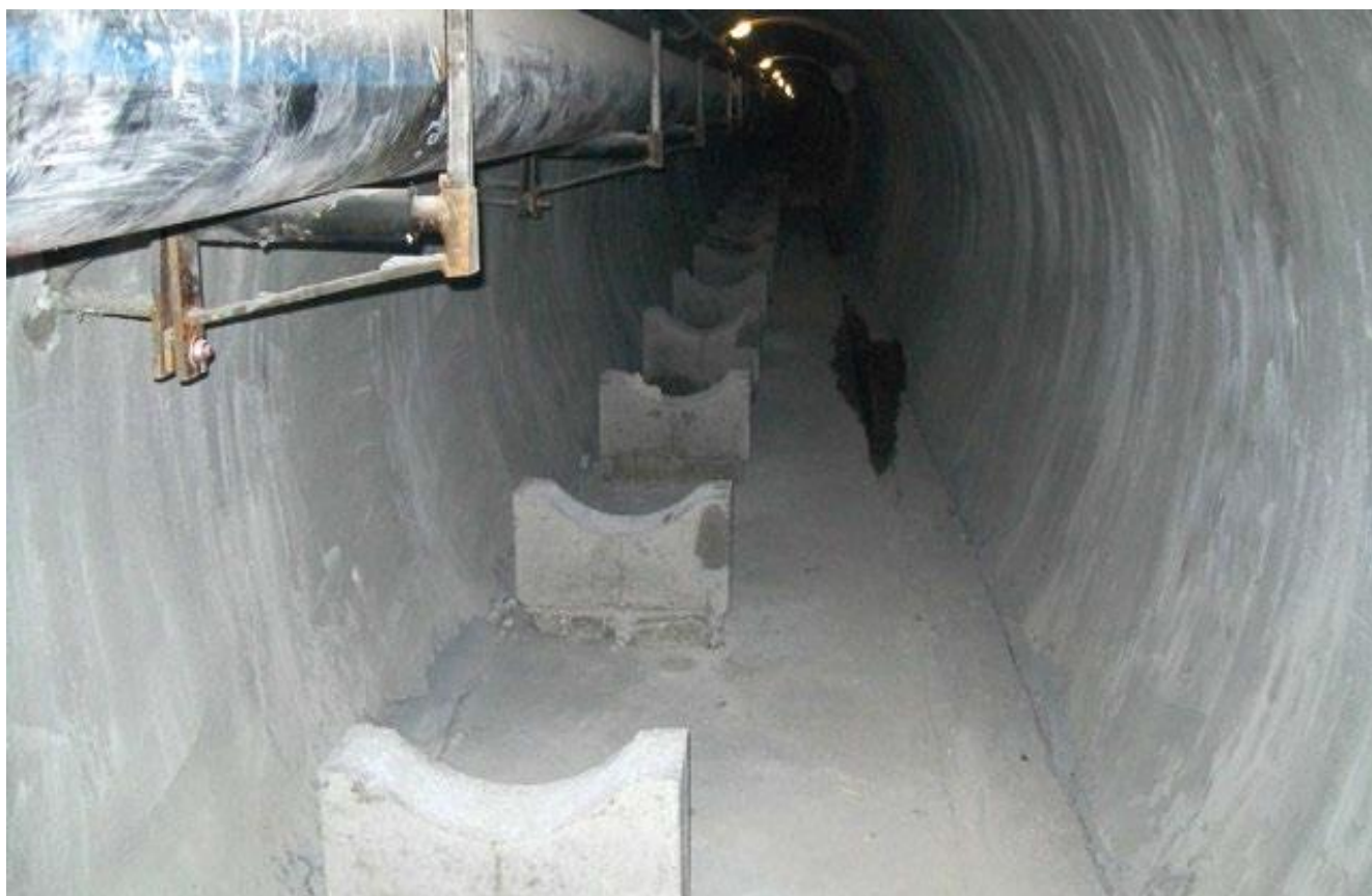
Figura 4 - Consolidamento statico delle gallerie Ascensione linea acquedottistica Pescara d'Arquata
