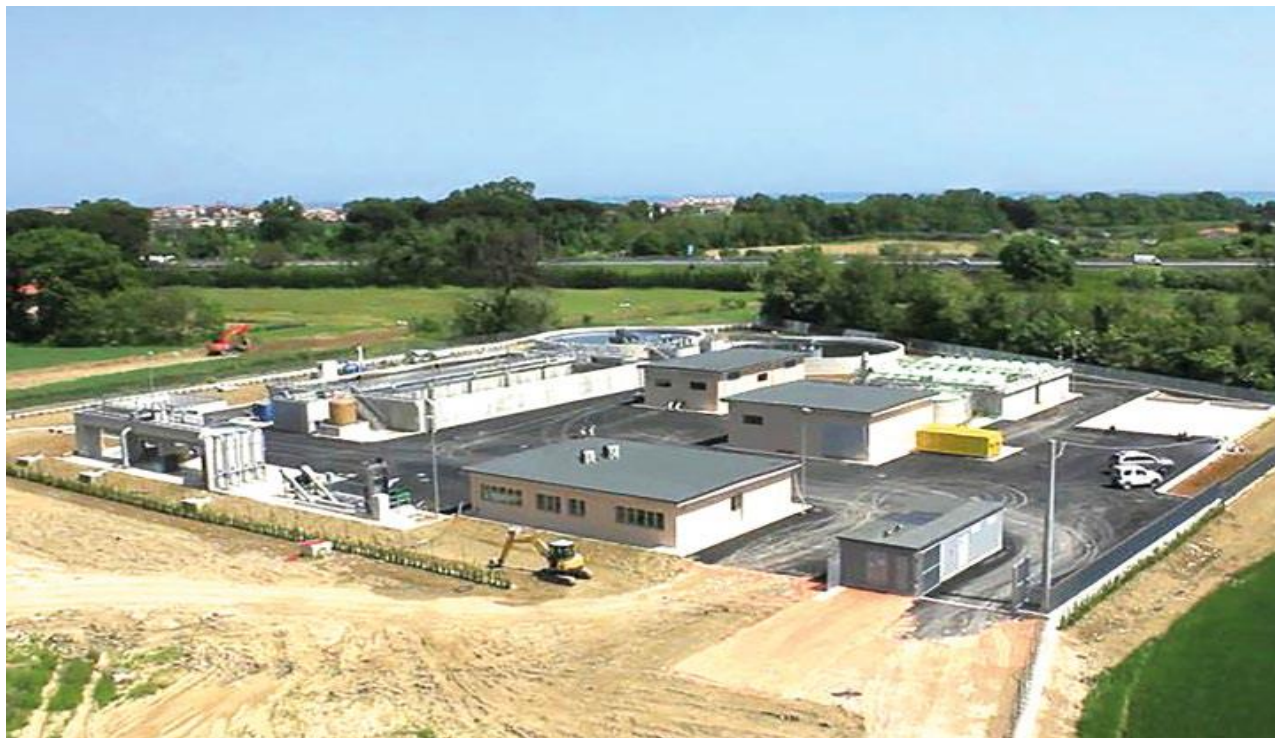
Figura 8 - Impianto di depurazione Basso Tenna con sistema integrato di depurazione e riutilizzo delle acque reflue mediante filtrazione a membrana.
