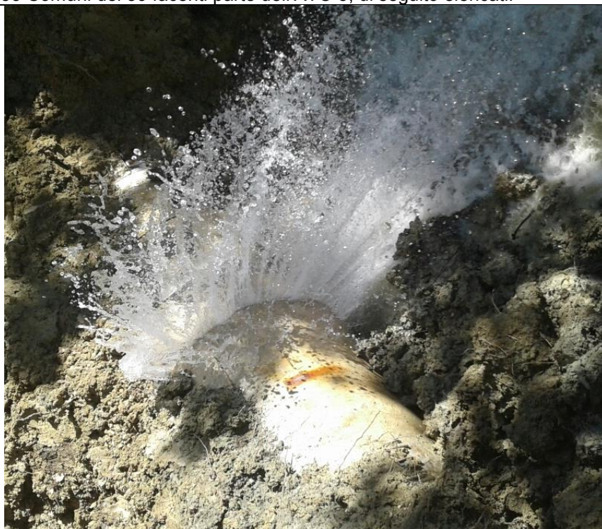
Figura 25 - Sisma 2016: Rottura condotta Acquedotto Pescara
