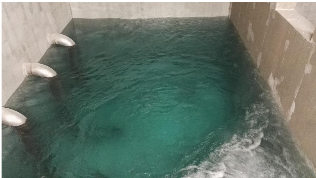
Figura 30 – Vasca accumulo Campo Pozzi Castel Trosino
