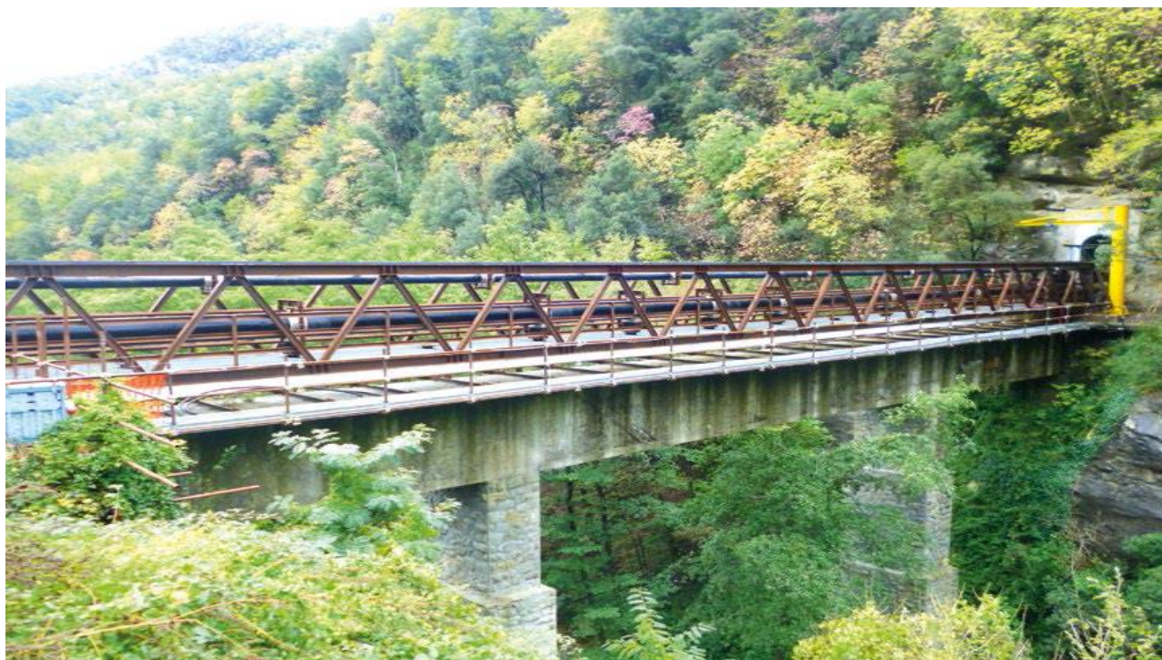
Figura 6 - Lavori di completamento del nuovo ponte-tubo Novele.
