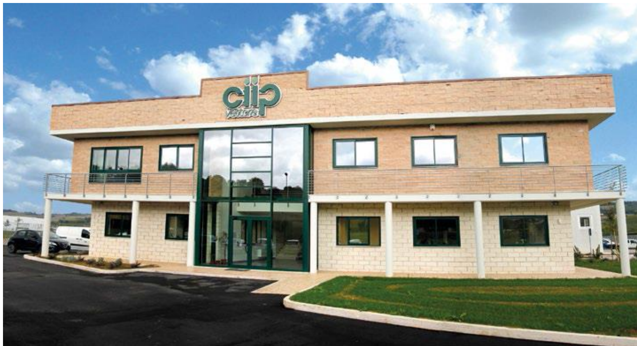
Figura 22 - Realizzazione della nuova sede del Centro Zona di Fermo
