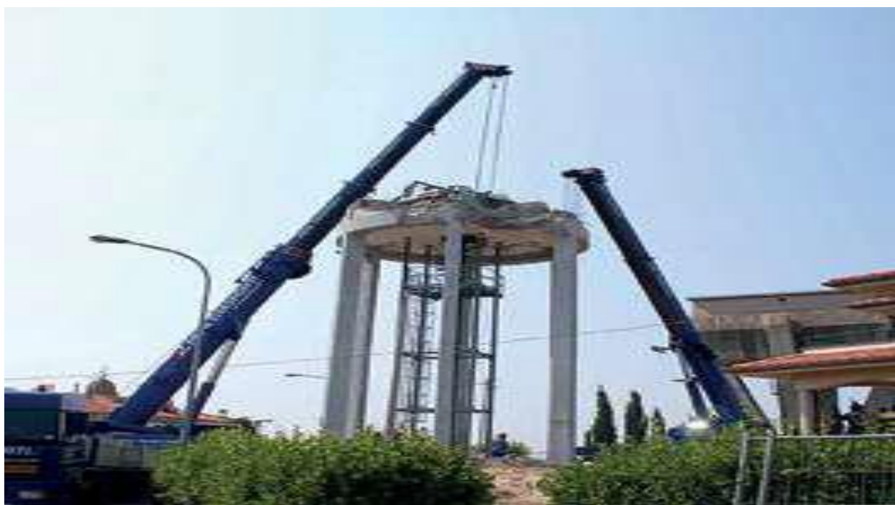
Figura 15 - Monte Giberto - Demolizione del vecchio serbatoio
