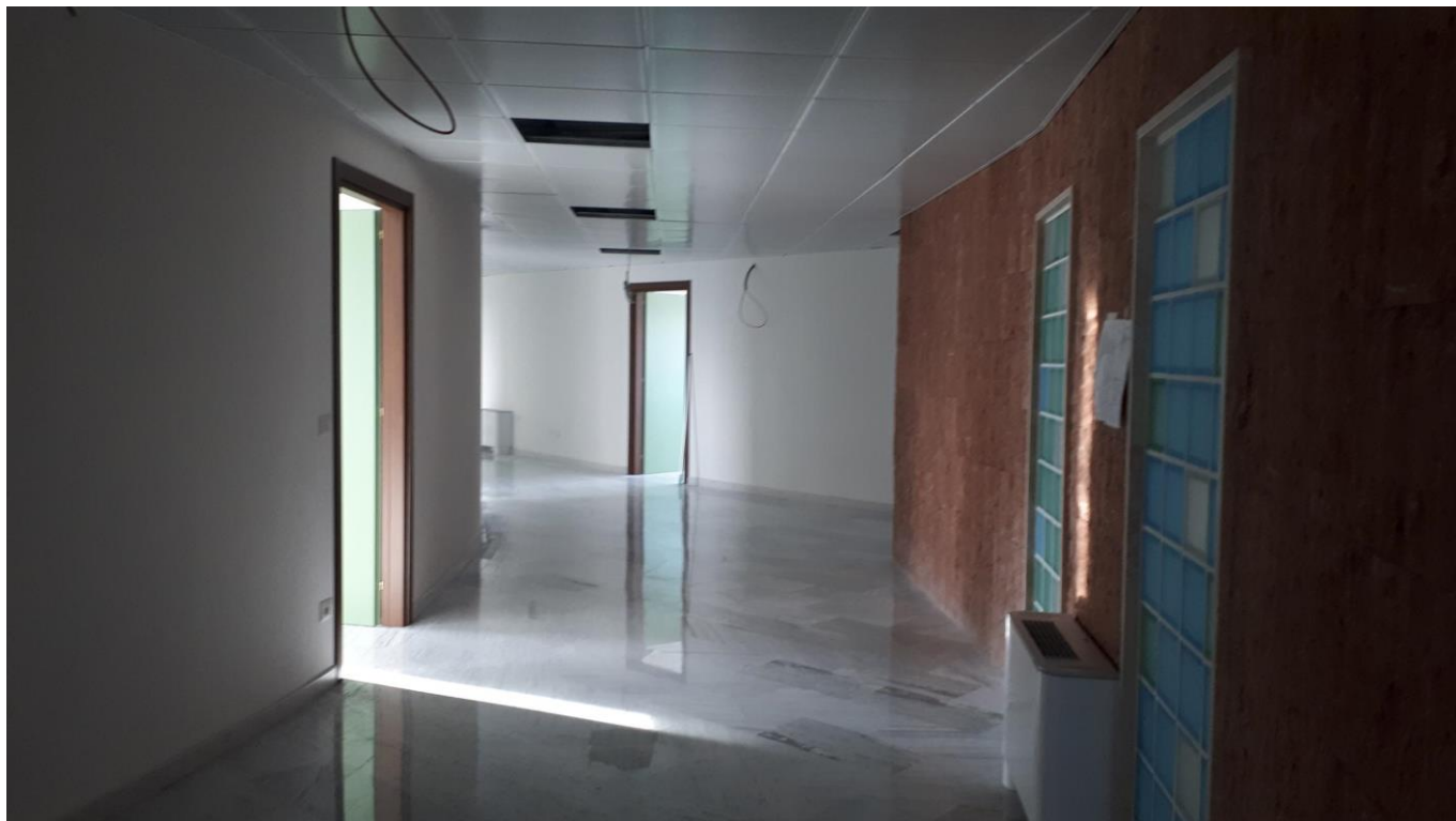
Figura 24 - Completamento 4° e 5° piano Sede Ascoli Piceno
