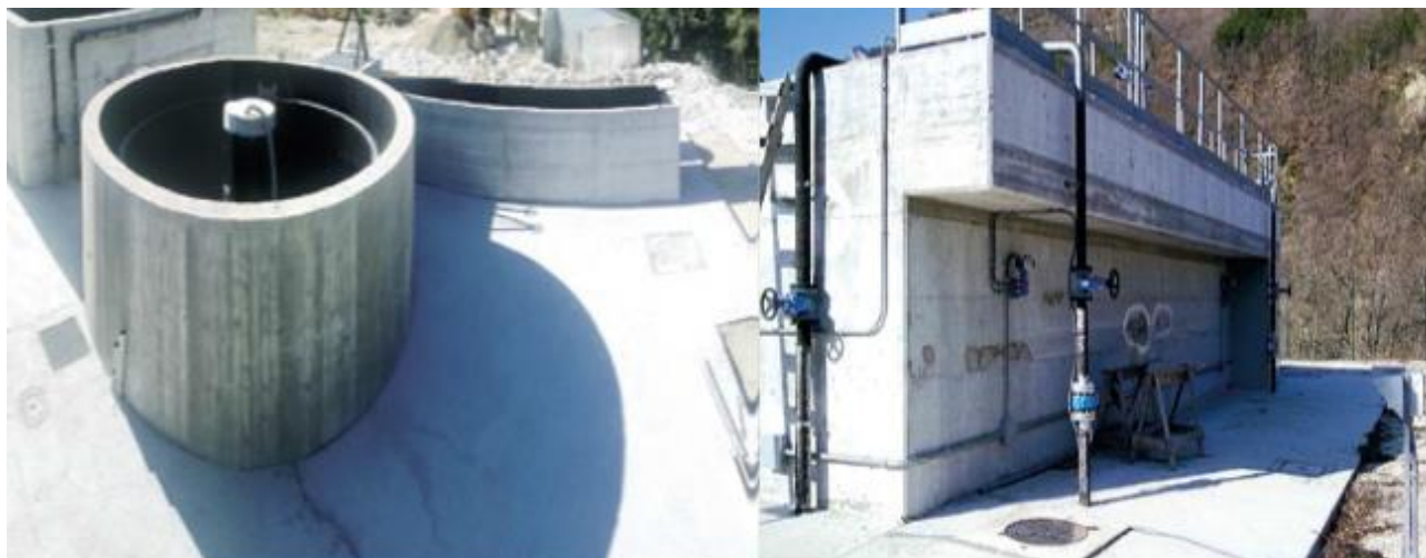
Figura 10 - Realizzazione di rete fognaria e depuratore a servizio delle frazioni di Centrale, Corneto, Paggese e Santa Maria di Acquasanta Terme
