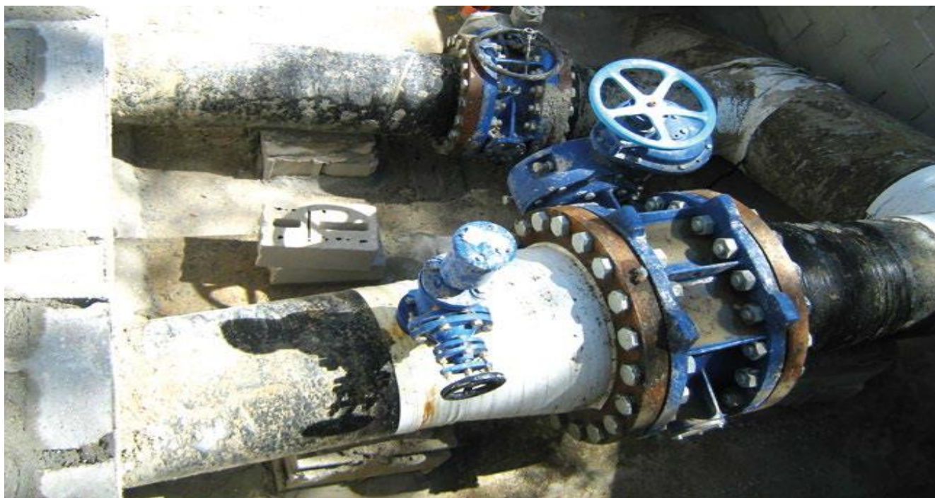
Figura 5 - Consolidamento statico dei ponti - tubo sulle linee acquedottistiche Pescara d'Arquata e Sibillini - 3° lotto
