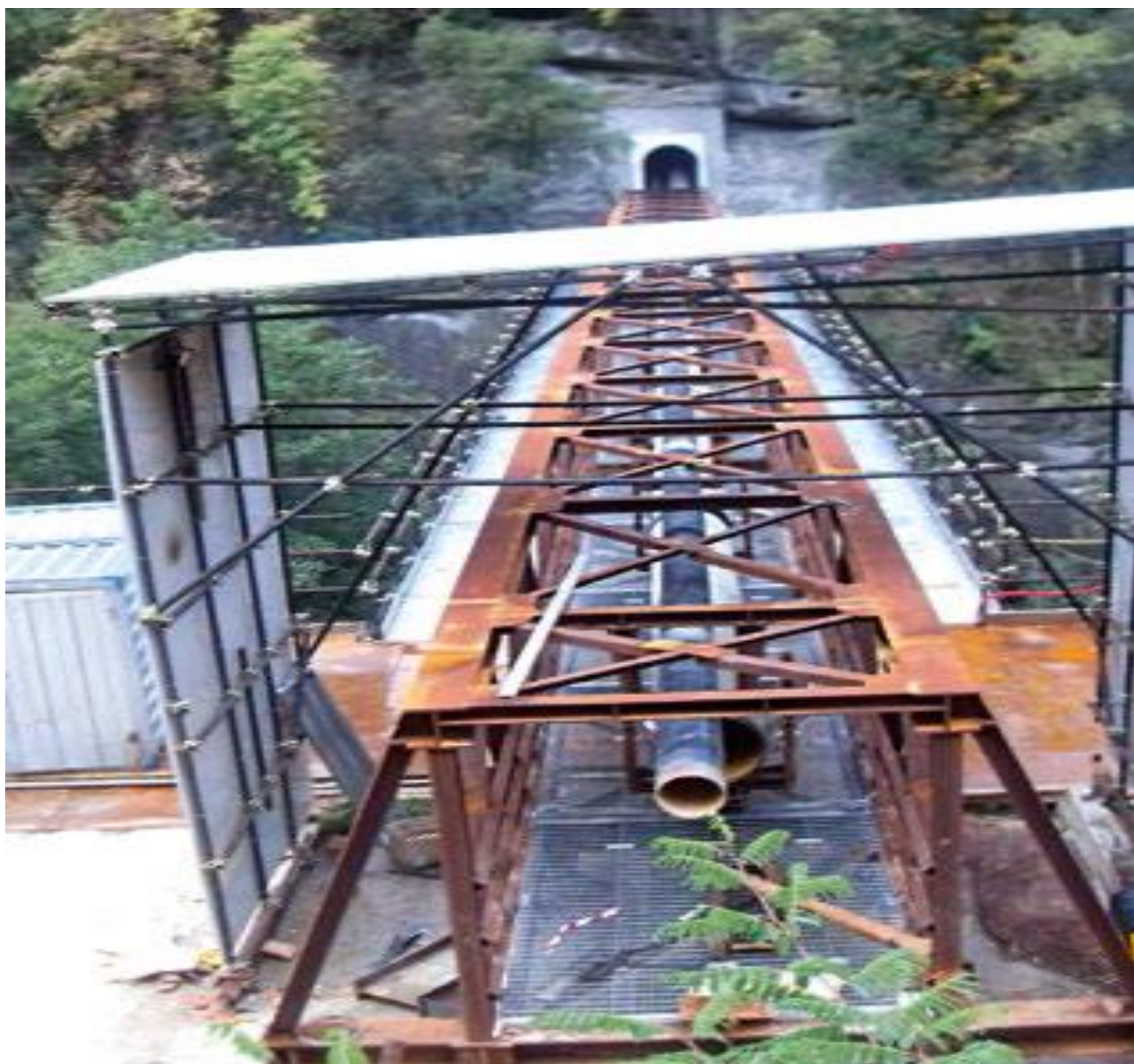
Figura 32 - Ponte Novele (Acquasanta Terme)
