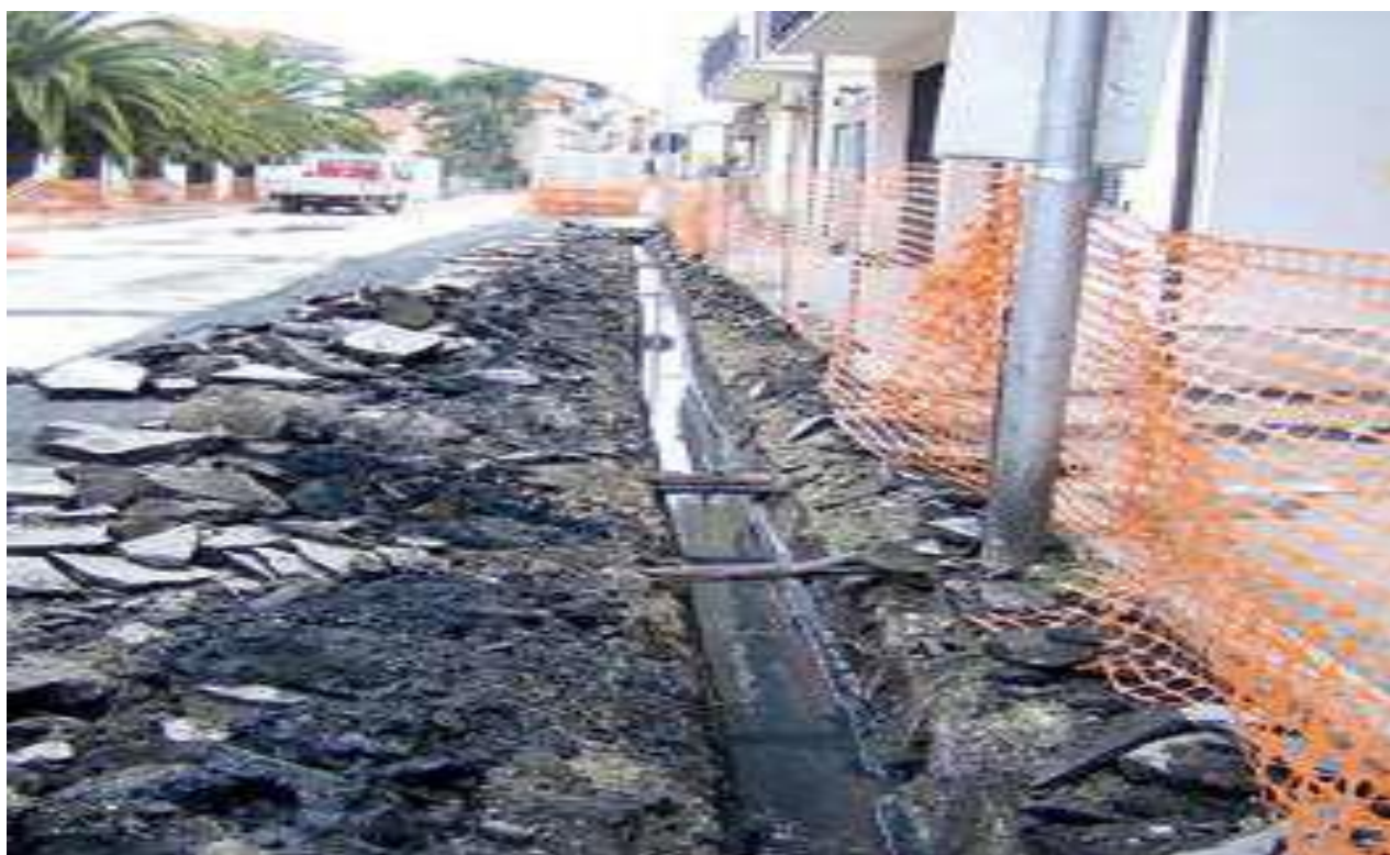
Figura 13 - Scavo per la realizzazione della rete idrica, zona Porto D'ascoli-San Benedetto del Tronto
