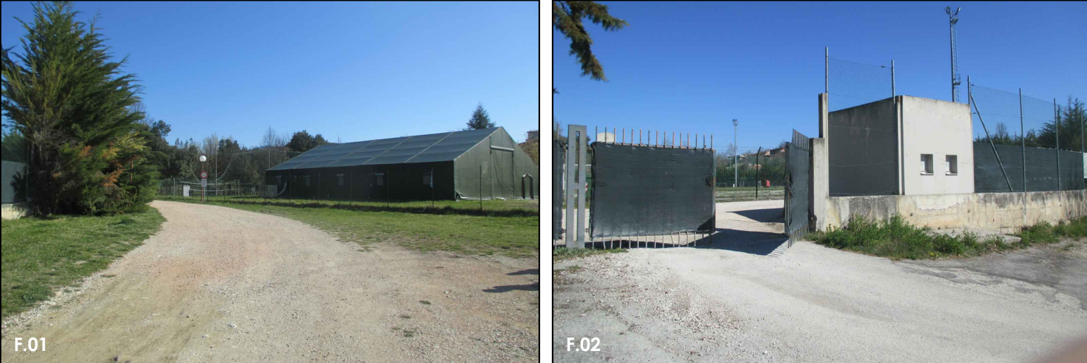
DOCUMENTAZIONE FOTOGRAFICA DELL'AREA D'INTERVENTO E DELLE STRUTTURE PRESENTI
