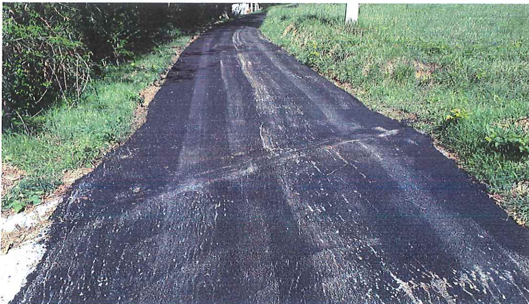
Fraz. Capodipiano (Strada Mancini) – Situazione post intervento
