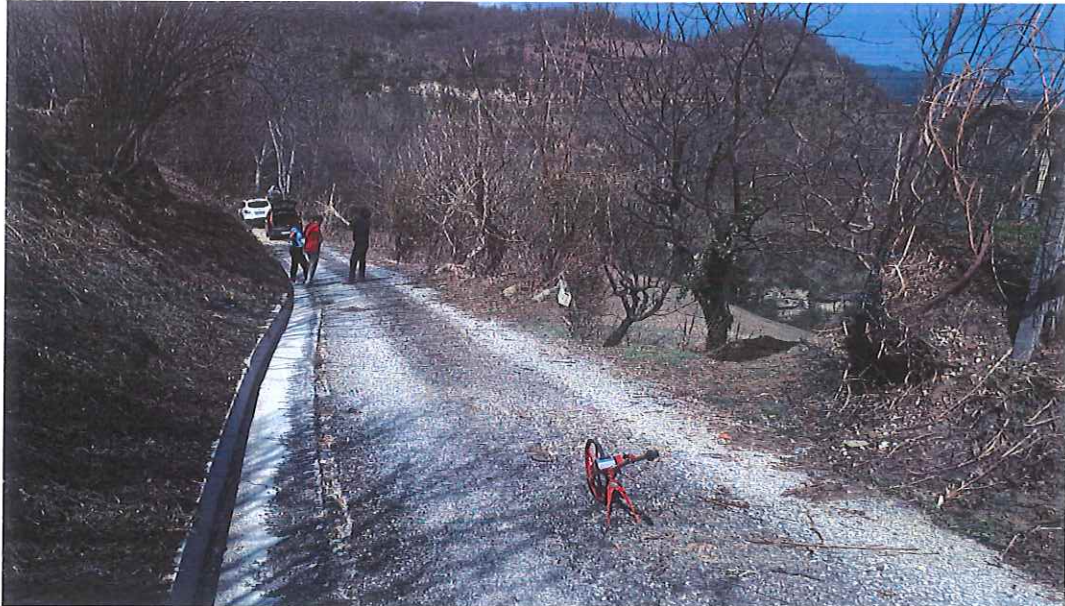
Fraz. Gimigliano (Strada Galanti-Tappatà) – Situazione pre intervento
