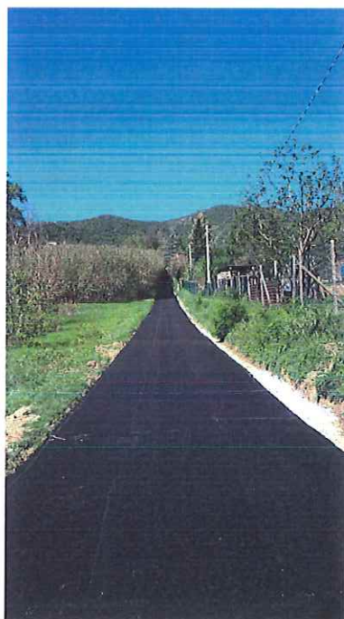
Fraz. Capodipiano (Strada Mancini) – Situazione post intervento
