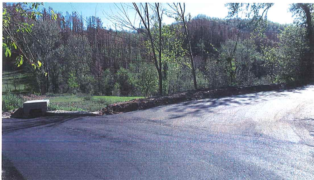
Fraz. Capodipiano (Strada Mancini) – Situazione post intervento
