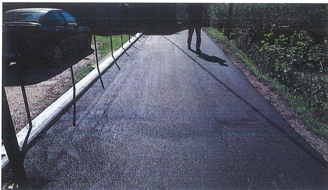
Fraz. Capodipiano (Strada Mancini) – Situazione post intervento
