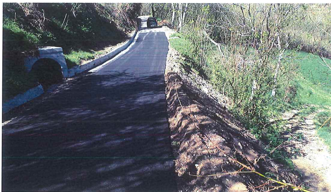
Fraz. Gimigliano (Strada Galanti-Tappatà) – Situazione post intervento
