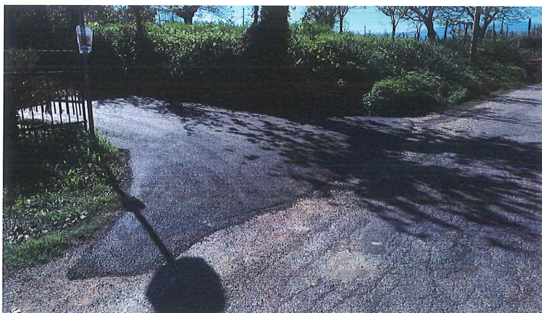
Fraz. Capodipiano (Strada Mancini) – Situazione post intervento
