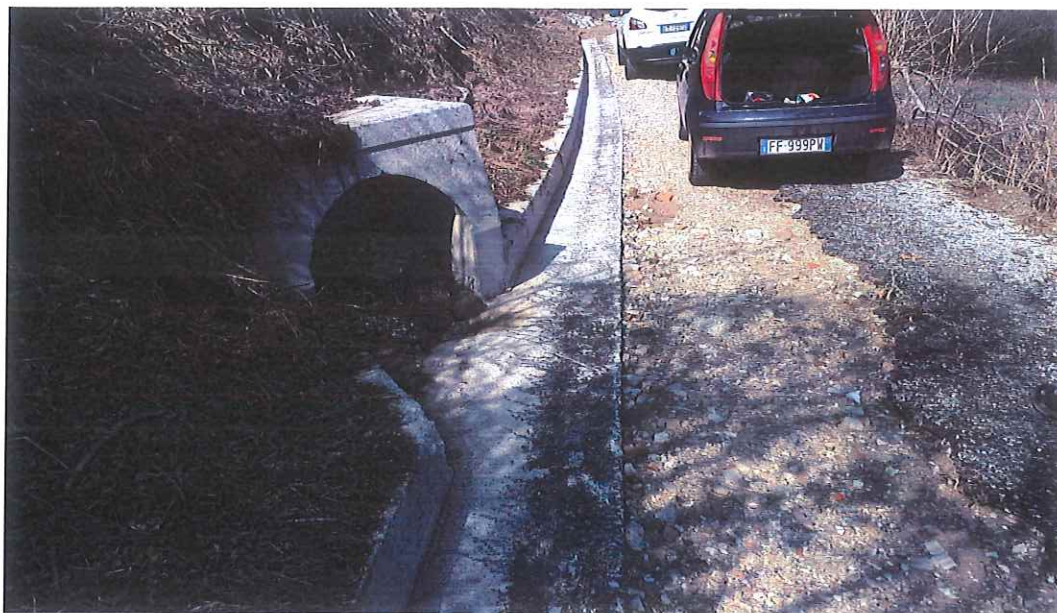
Fraz. Gimigliano (Strada Galanti-Tappatà) – Situazione pre intervento
