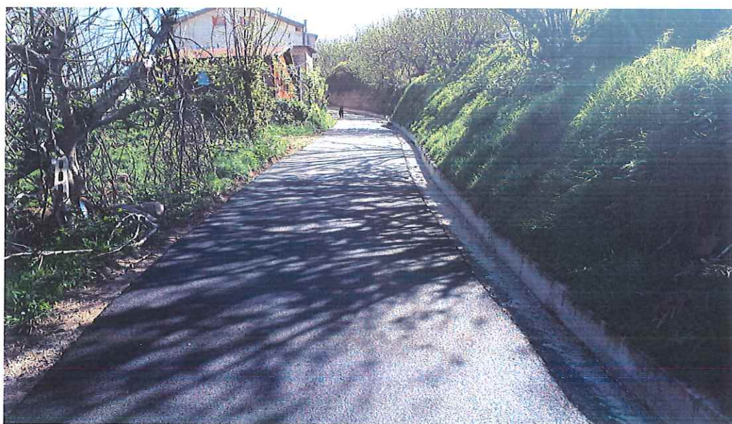
Fraz. Gimigliano (Strada Galanti-Tappatà) – Situazione post intervento
