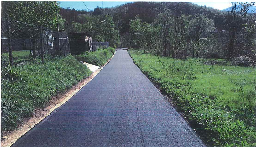
Fraz. Capodipiano (Strada Mancini) – Situazione post intervento
