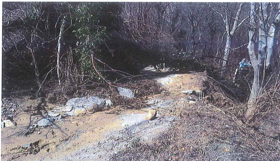
Fraz. Gimigliano (Strada Galanti-Tappatà) – Situazione pre intervento
