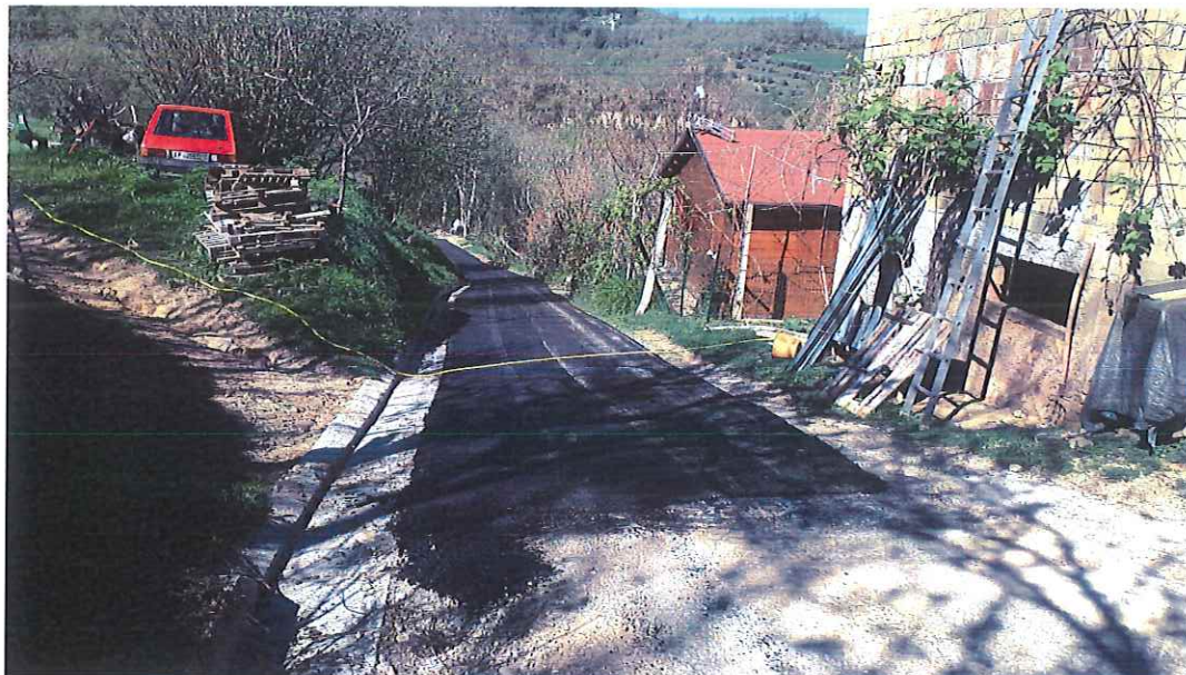
Fraz. Gimigliano (Strada Galanti-Tappatà) – Situazione post intervento
