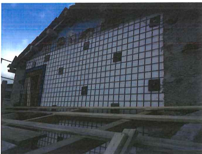
Dettaglio fissaggio rete elettrosaldata: parete esterna;
