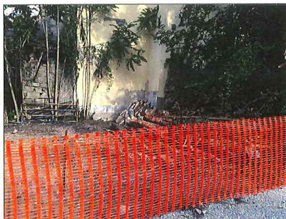
M.03 AREA STOCCAGGIO COPPI E TRAVI DEL MANTO DI COPERTURA
