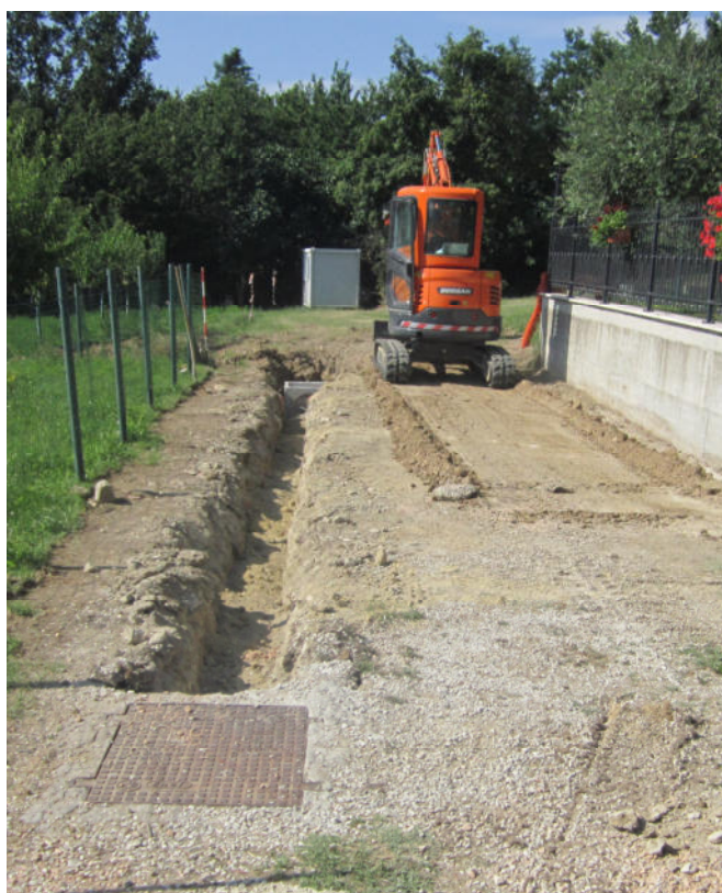
Voce libretto delle misure n°2 (Scavo a sezione obbligata fino a 2mt)
