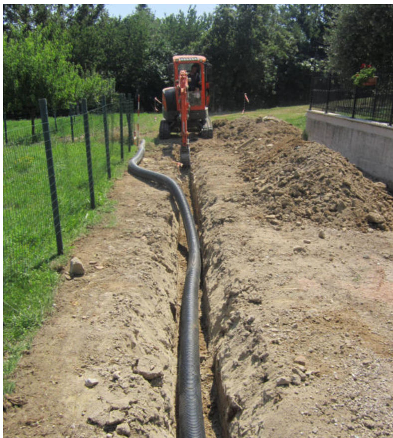
Voce libretto delle misure n°16 (Tubazione flessibile in polietilene mm160)
