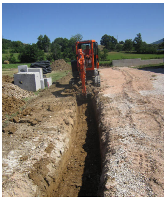
Voce libretto delle misure n°2 (Scavo a sezione obbligata fino a 2mt)
