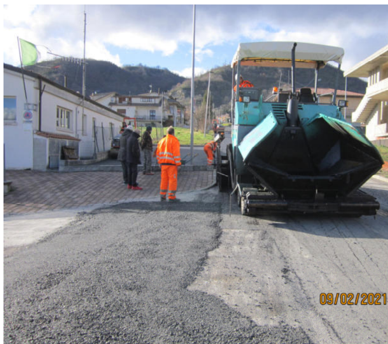
Voce libretto delle misure n°6 (Conglomerato bituminoso tipo binder chiuso)
