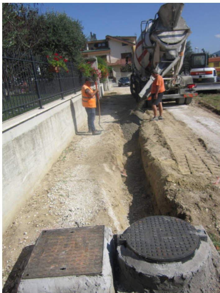
Voce libretto delle misure n°4 (Calcestruzzo magro)
