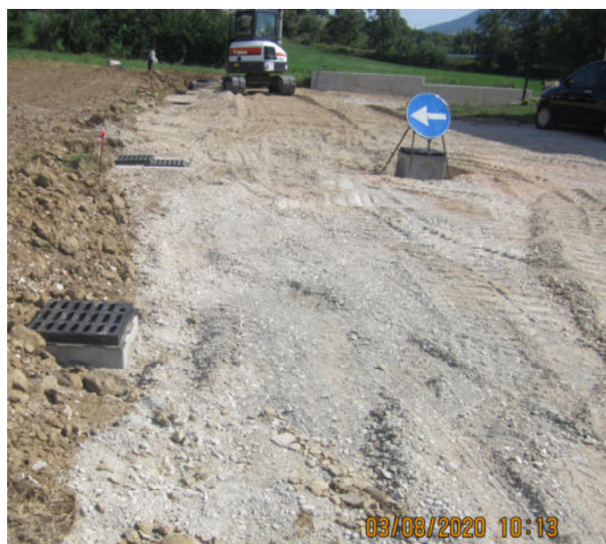
Voce libretto delle misure n°14 (Caditoie in ghisa sferoidale)
