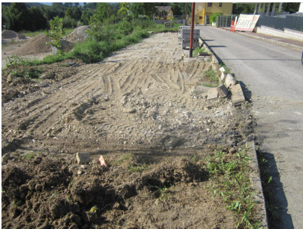
Voce libretto delle misure n°18 (preparazione del piano di posa con materiali inerti)
