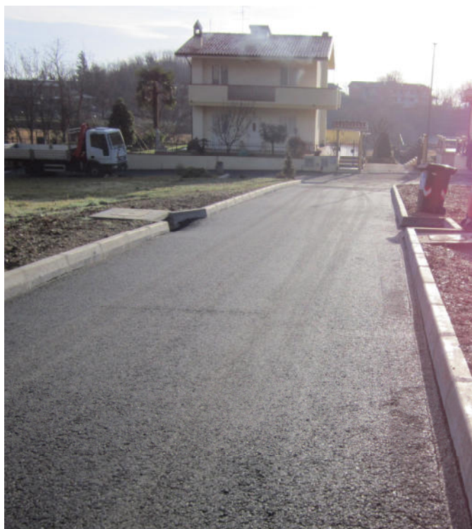
Voce libretto delle misure n°6 (Conglomerato bituminoso tipo binder chiuso)
