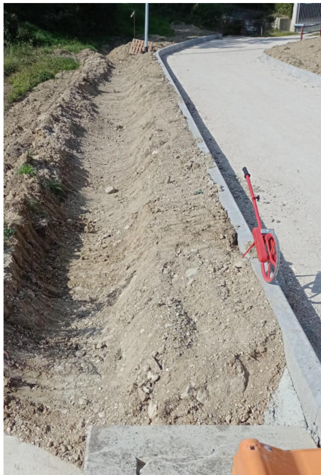
Voce libretto delle misure n°19 (Riempimento con materiale proveniente da scavi di cantiere)
