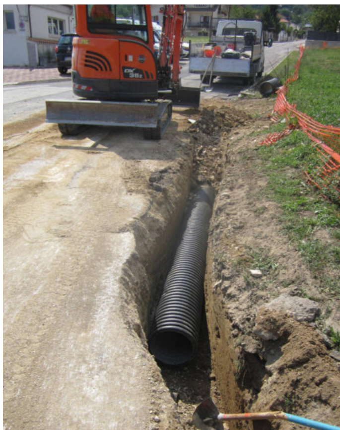
Voce libretto delle misure n°22 (Posa in opera tubo in PEAD SN4 corrugato mm400)
