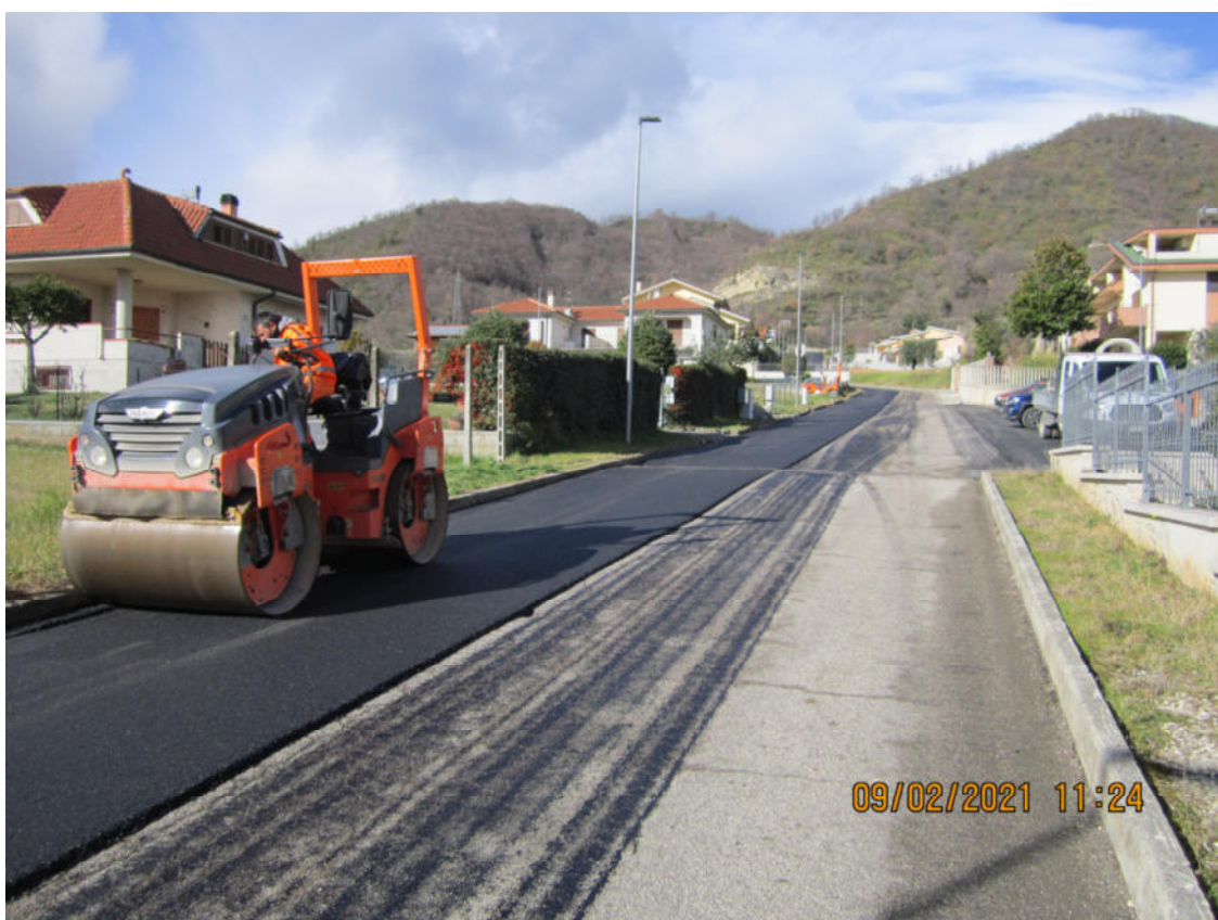
Voce libretto delle misure n°27 (Conglomerato bituminoso tipo tappetino)
