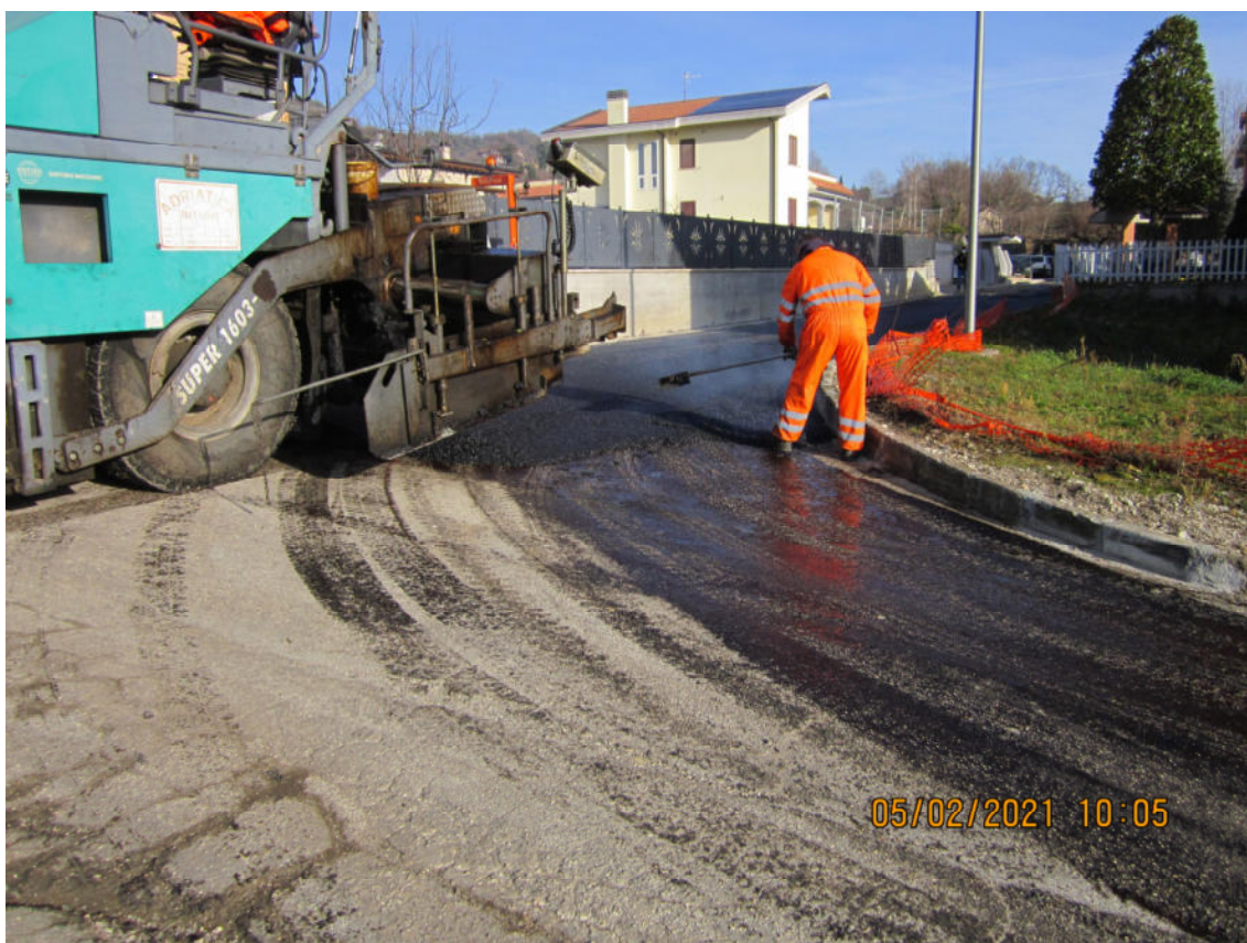
Voce libretto delle misure n°27 (Conglomerato bituminoso tipo tappetino)
