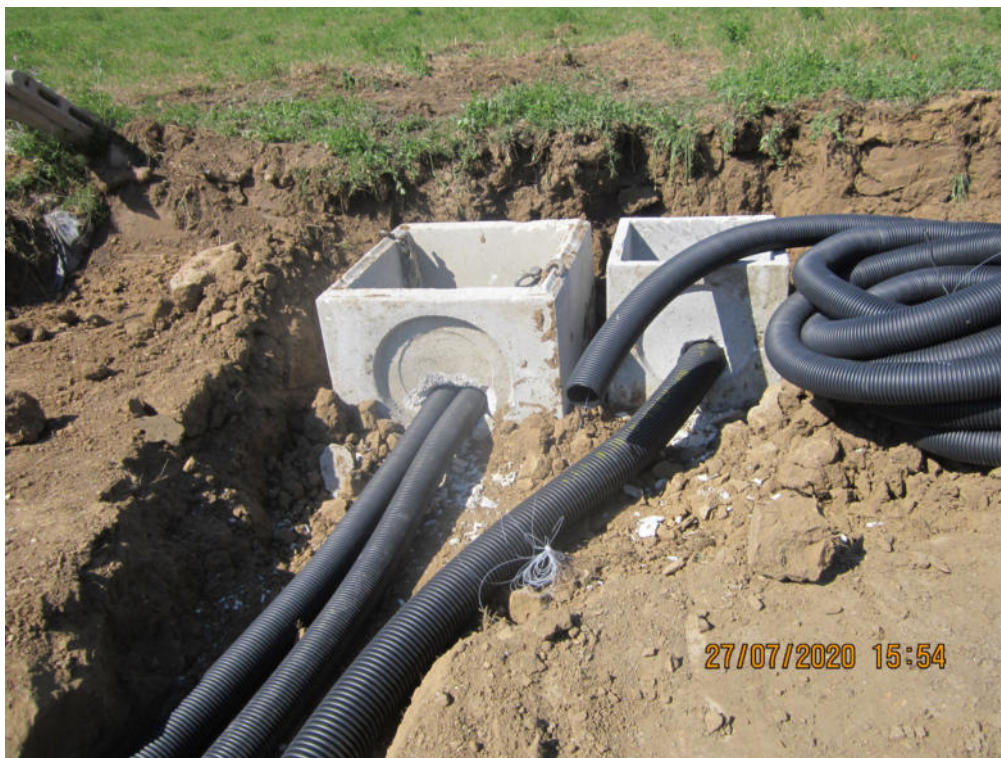
Voce libretto delle misure n°17 (Tubazione flessibile in polietilene mm125)
