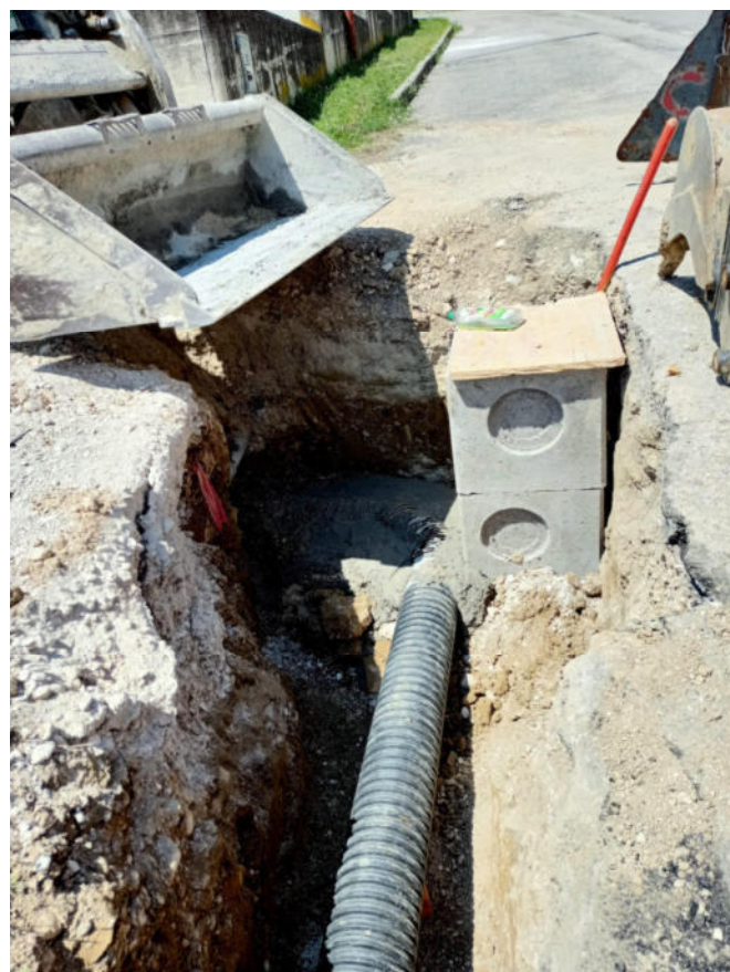
Voce libretto delle misure n°12 (Posa in opera tubo in PEAD SN4 corrugato mm200)
