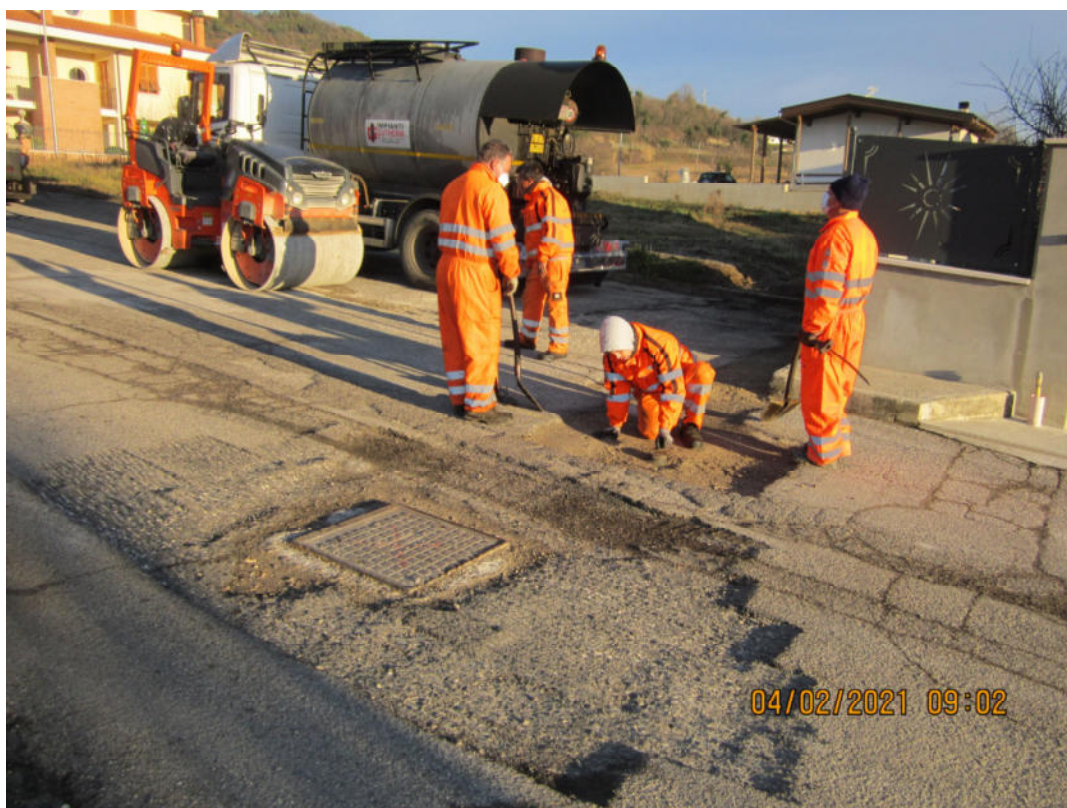
Voce libretto delle misure n°30 (Fresatura di pavimentazione stradale)
