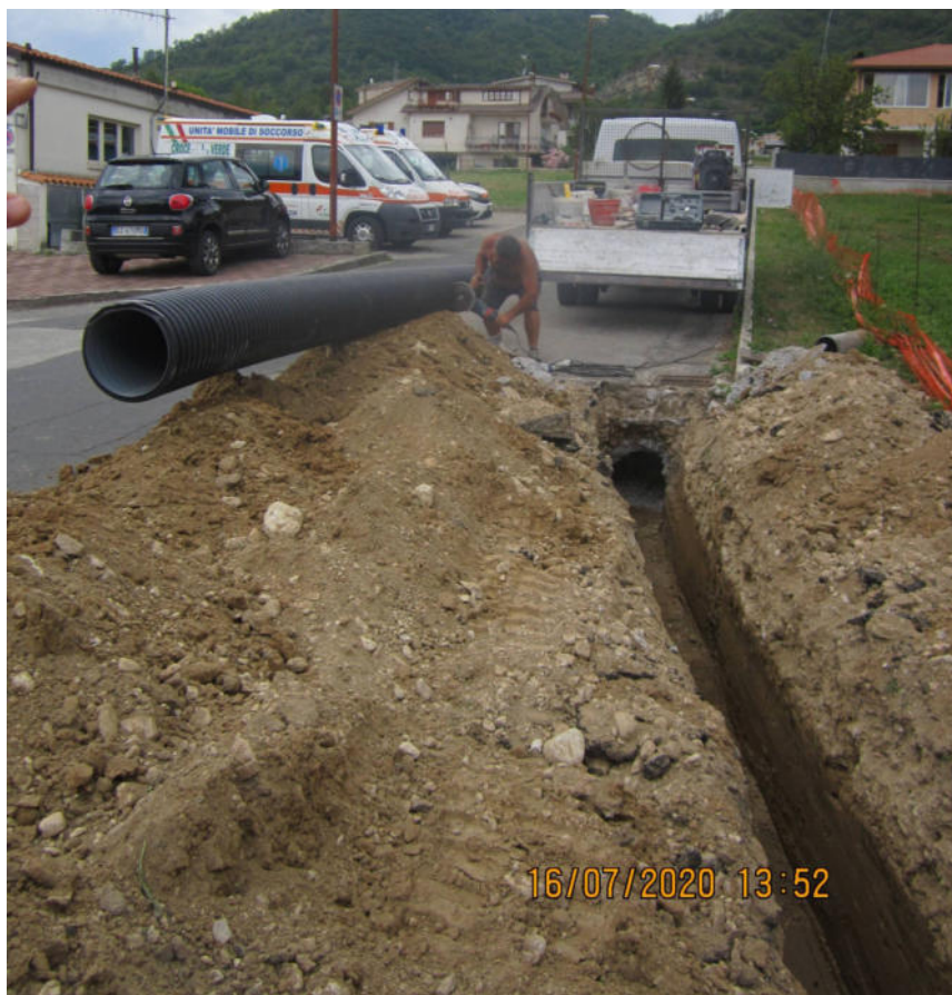
Voce libretto delle misure n°21 (Scavo a sezione obbligata fino a 3 mt)
