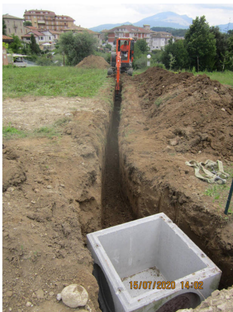
Voce libretto delle misure n°22 (Scavo a sezione obbligata fino a 3 mt)
