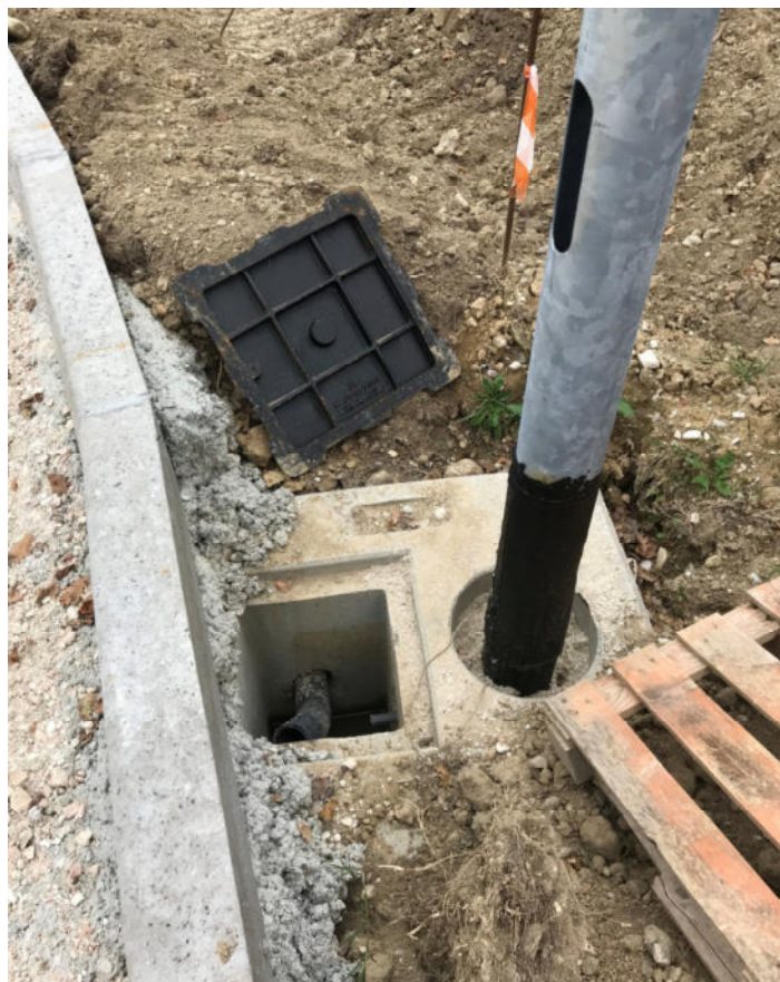
Voce libretto delle misure n°9 (Plinto prefabbricato per palo pubblica illuminazione)
