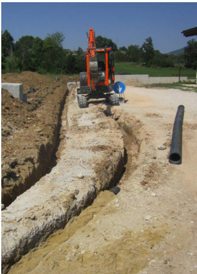
Voce libretto delle misure n°12 (Posa in opera tubo in PEAD SN4 corrugato mm200)
