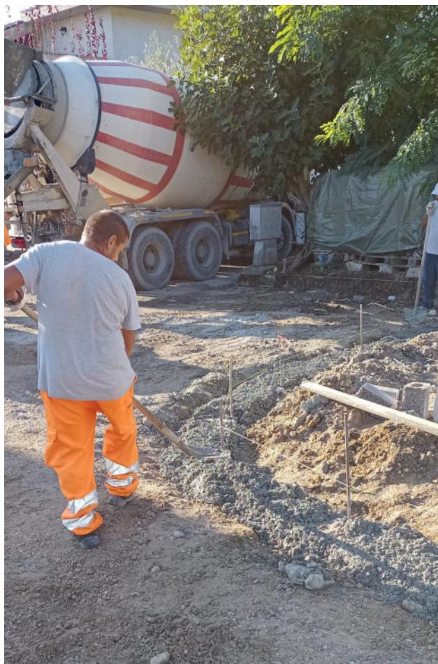
Voce libretto delle misure n°25-26 (Conglomerato cementizio – fondazione cordolo e zanella)
