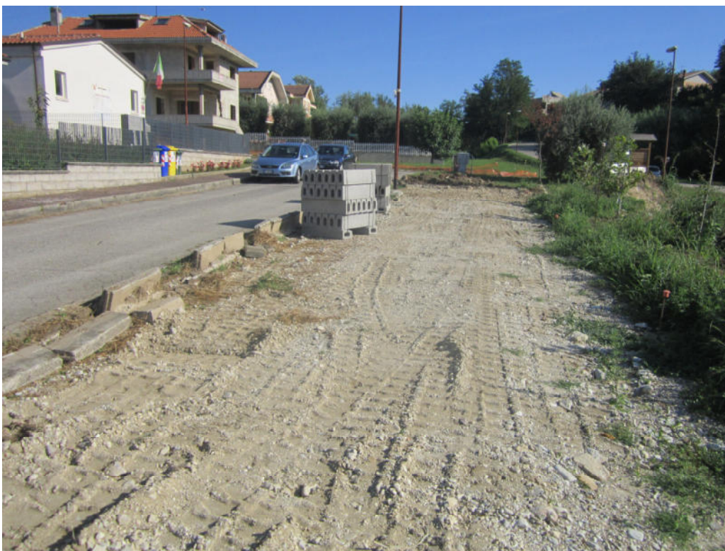
Voce libretto delle misure n°11 (Riempimento con misto di recupero)
