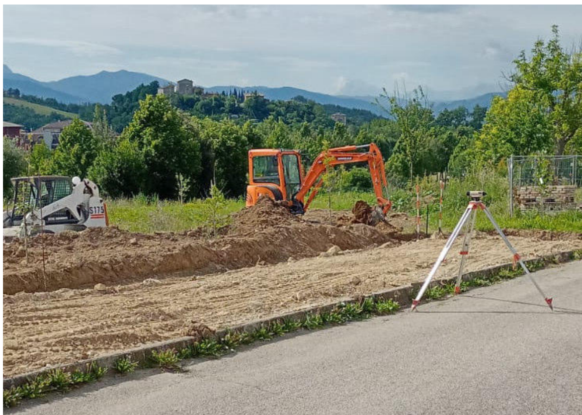
Voce libretto delle misure n°23 (Preparazione piano di posa dei rilevati con materiali da cava)
