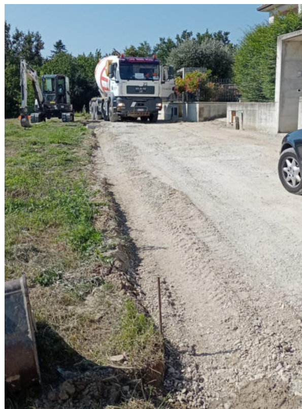
Voce libretto delle misure n°10 (Fondazione stradale in misto granulometrico)
