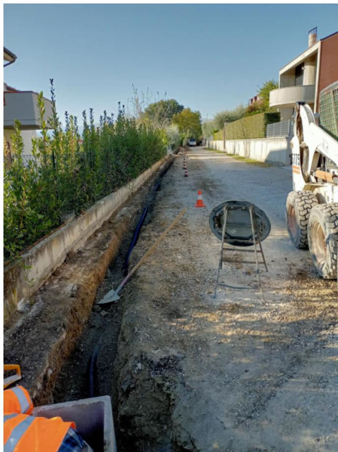
Voce libretto delle misure n°3 (Tubazione flessibile in polietilene mm75)
