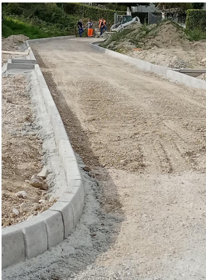
Voce libretto delle misure n°15 (Cordolo prefabbricato in cls vibrato)
