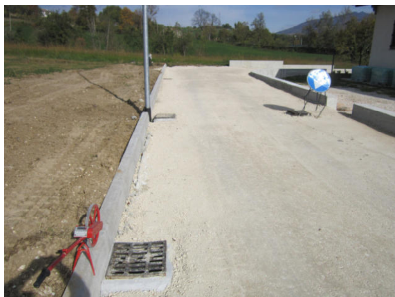
Voce libretto delle misure n°14 (Caditoie in ghisa sferoidale)
