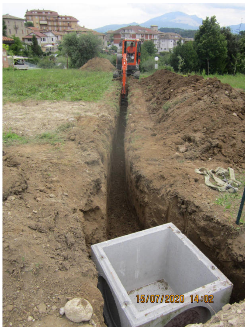
Voce libretto delle misure n°21 (Scavo a sezione obbligata fino a 3 mt)
