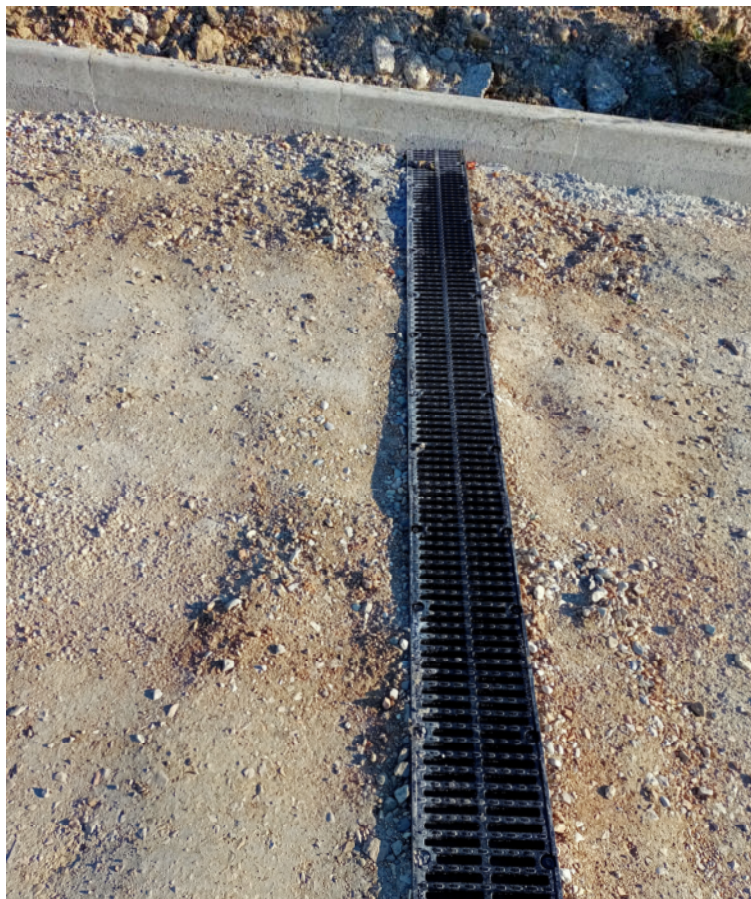
Voce libretto delle misure n°13 (Griglia in ghisa sferoidale)
