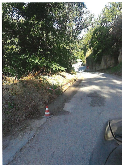
Immagine #8-9 – Rifacimento canalette
