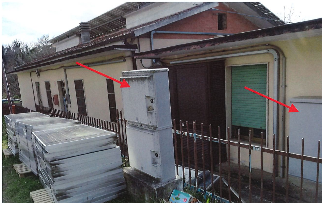
Foto n.7 – Vista alloggiamento contatori produzione e fornitura ente distributore (pre-intervento)
