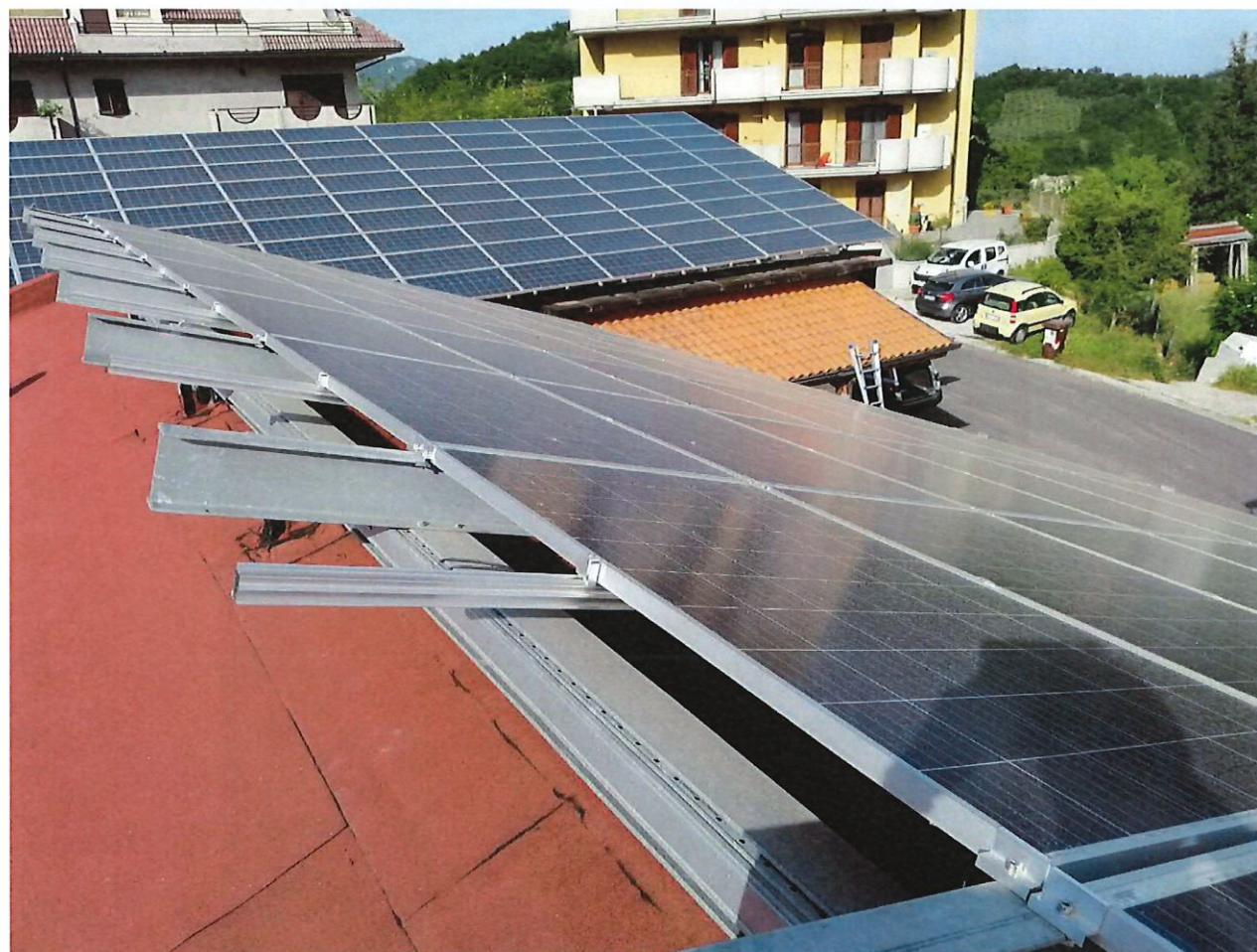
Foto n.5 – Vista vecchi moduli fotovoltaici su copertura scuola materna (post-intervento)
