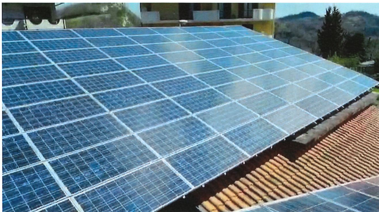
Foto n.4 – Vista vecchi moduli fotovoltaici su copertura scuola materna (pre-intervento)
