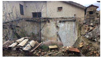
1 Dettaglio: effettuare sarcitura lesioni dopo demolizione
