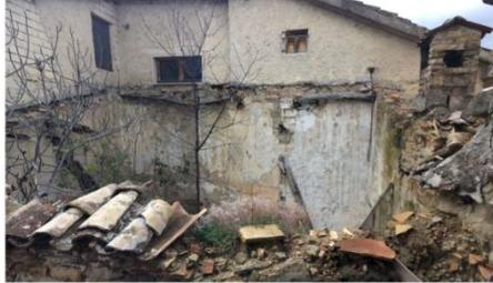
1 Dettaglio: effettuare sarcitura lesioni dopo demolizione
