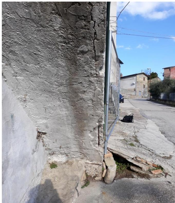
*Foto 15 – Lesioni diffuse su scala di collegamento Piano Terra – Primo Piano*
