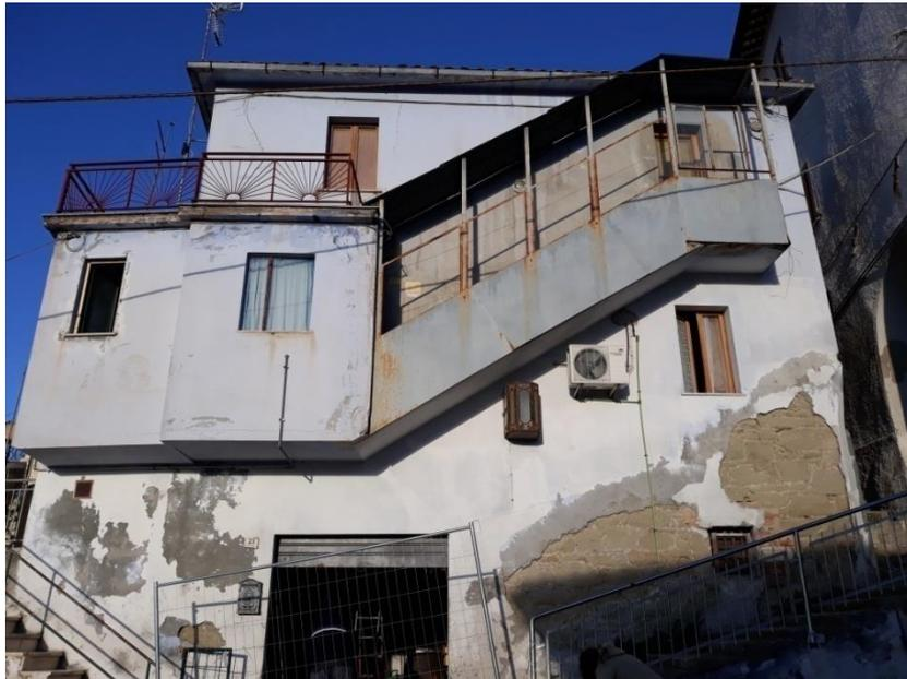
*Foto 5 – Corpo in aggetto al Piano primo e scala esterna in aggetto di collegamento al Piano secondo*
