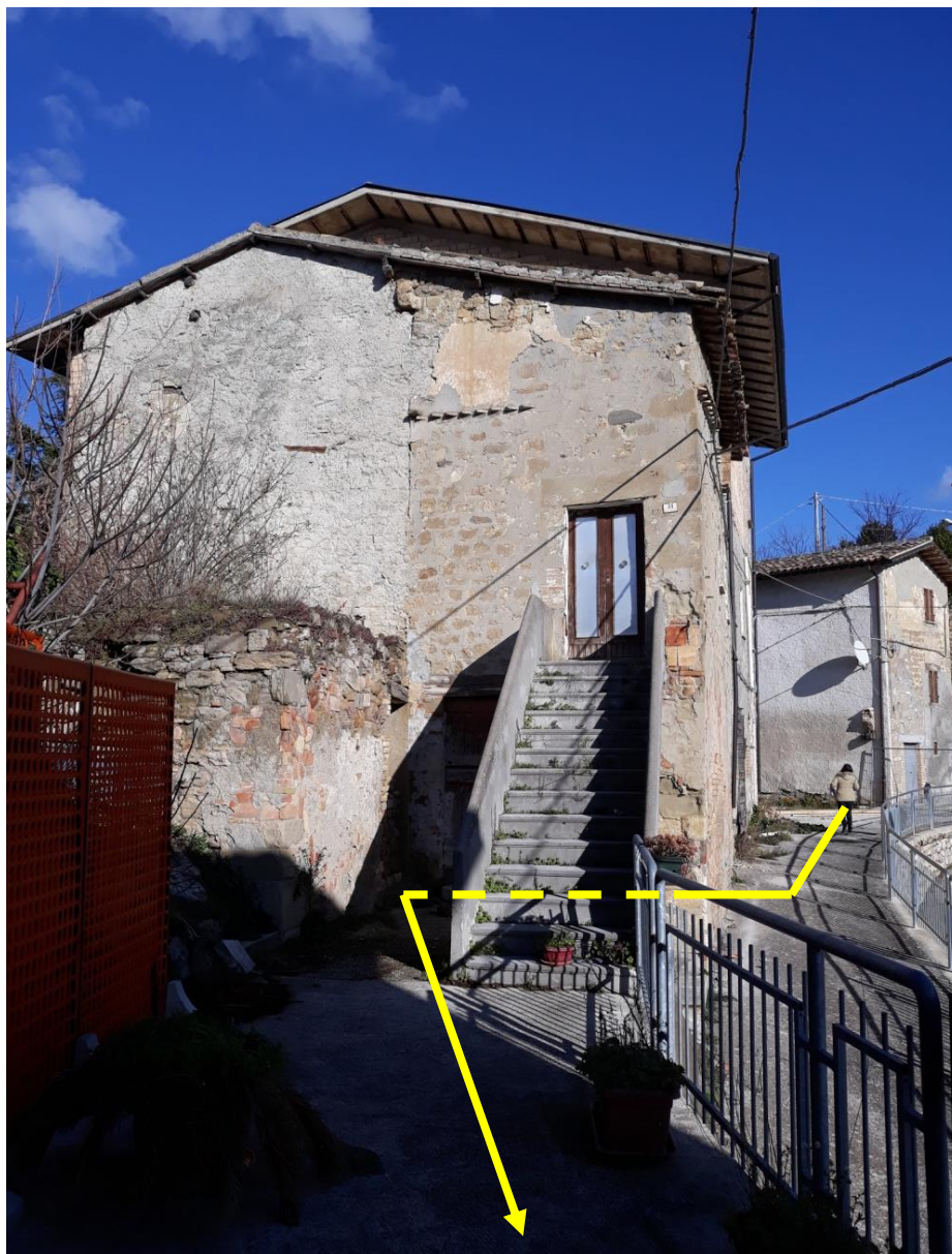
Foto 7 – Percorso di accesso pedonale verso l'edificio Part. 179
