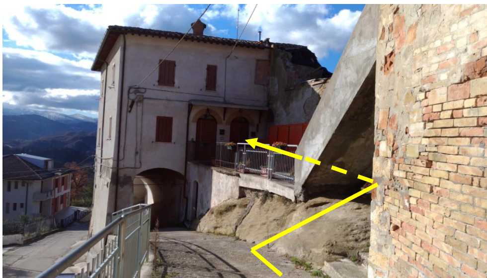
Foto 6— Percorso di accesso pedonale verso l'edificio Part. 179
