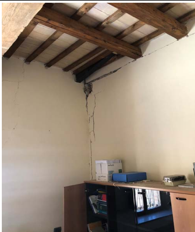
Foto F13 – Vista su piano secondo Palazzo Pallotta
