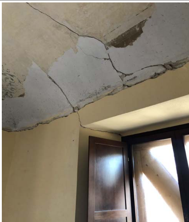
Foto F12 – Vista su piano secondo Palazzo Pallotta
