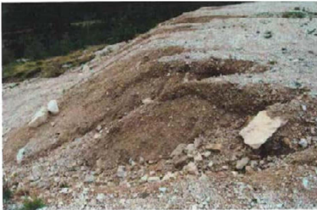
**Foto n°10** – Particolare della foto precedente: panoramica da altra angolazione con particolare riferimento ai massi (trovanti calcarei) presenti al bordo della scarpata in condizioni di equilibrio instabile
