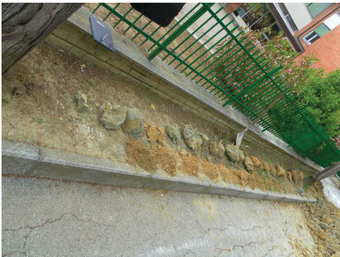
SONDAGGIO S3: da 0.0 mt a 37.0 mt
