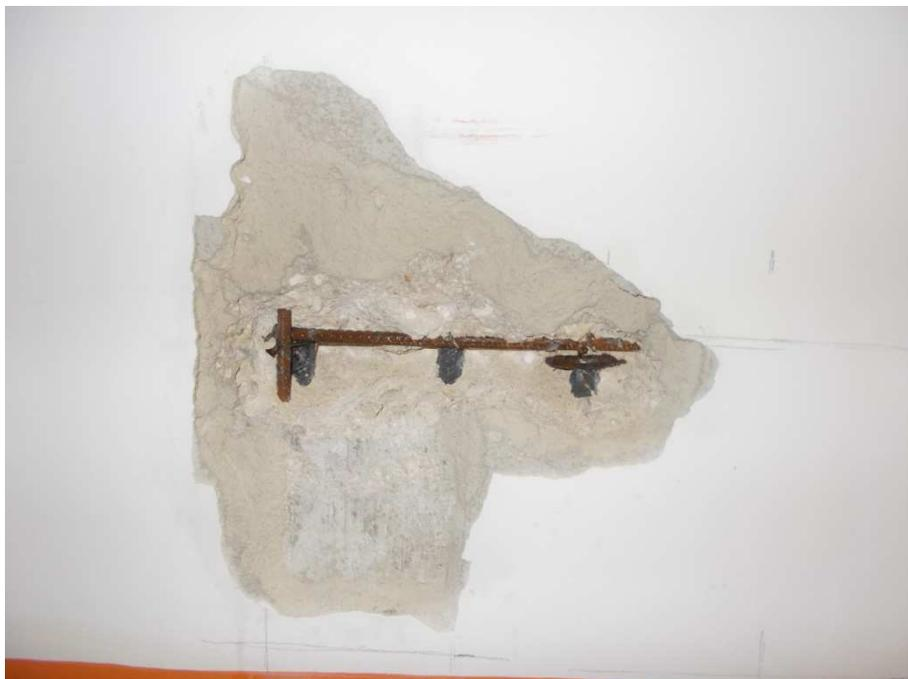
**FOTO 1 – Piano Terra, Pilastro 10.** Ferri di armatura n. 1÷3 e staffa, individuati nella tabella 2.1
