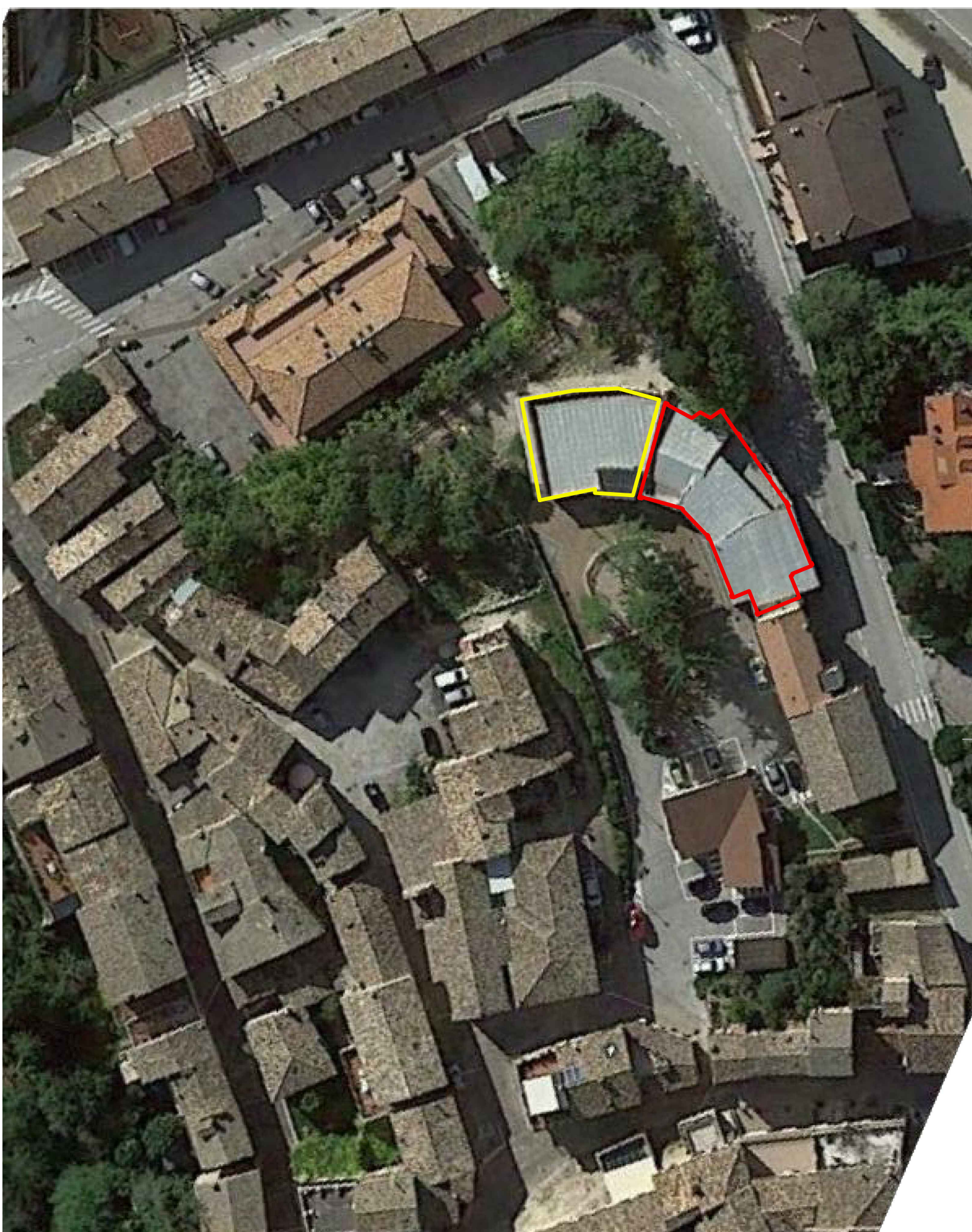
FOTO AEREA FUORI SCALA
