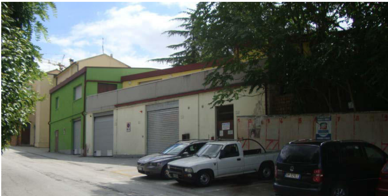
Vista aerea sull'edificio, foto del prospetto a monte, foto del prospetto su strada.
