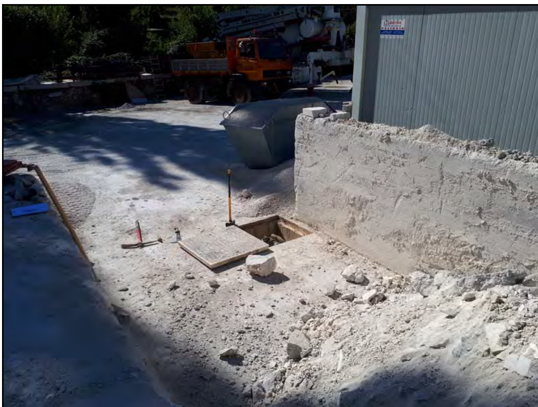
Foto 2 - Area su cui è stato realizzato il pozzo
