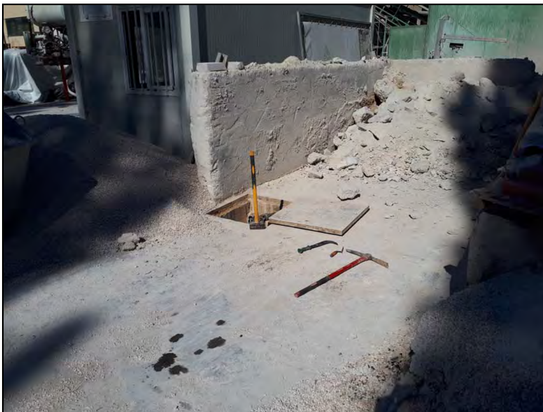
Foto 1 - Area su cui è stato realizzato il pozzo
