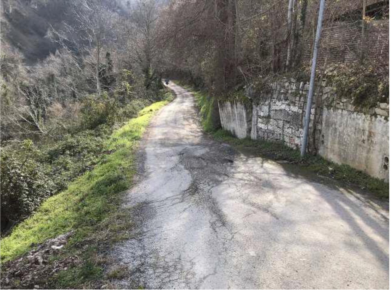
Km 0+020 – frana scarpata di valle e cedimento opera di sostegno di monte
