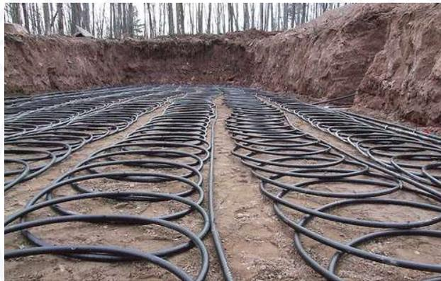
*Figura 1 – Esempio di disposizione delle sonde geotermiche in senso orizzontale.*
