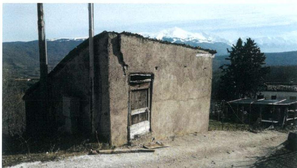
Il manufatto è costituito da 2 livelli, dei quali uno è posto ad una quota inferiore al piano stradale. Le strutture verticali portanti sono in pietrame non squadrate, a tessitura irregolare e di cattiva qualità, senza catene o cordoli. La copertura è del tipo non spingente leggera.
