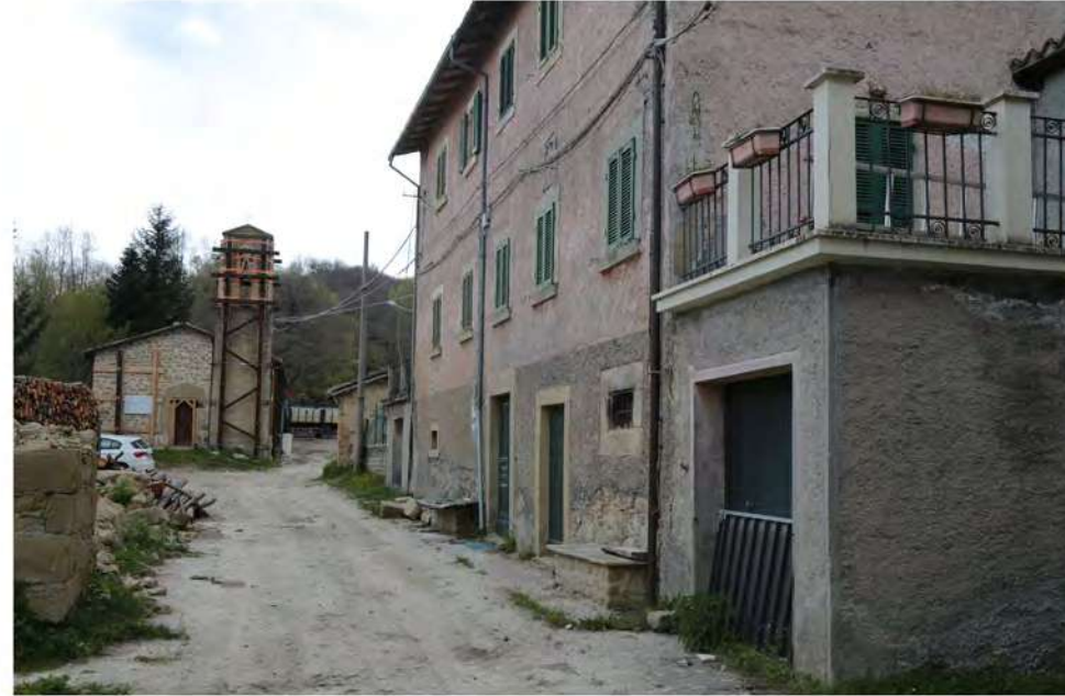
EDIFICIO STORICO DI PREGIO - PART.LLA 44
