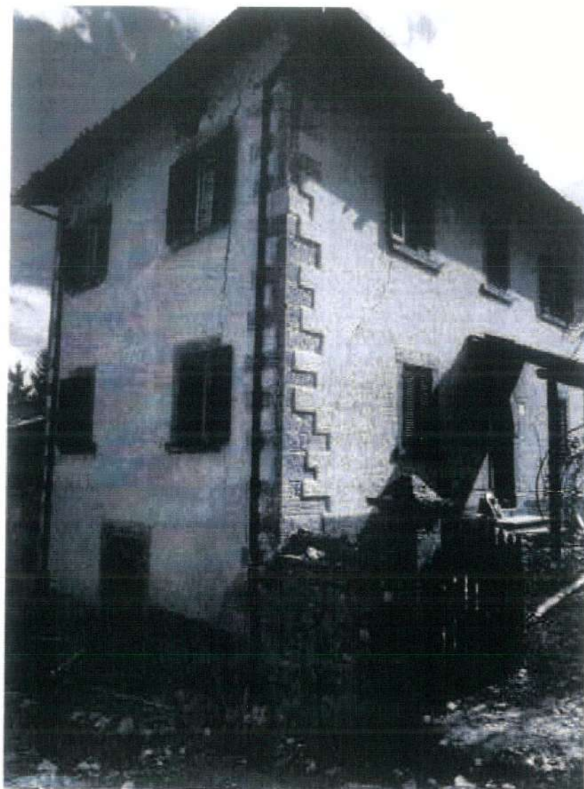
FOTO -1- (P.lla 125 sub 2)
