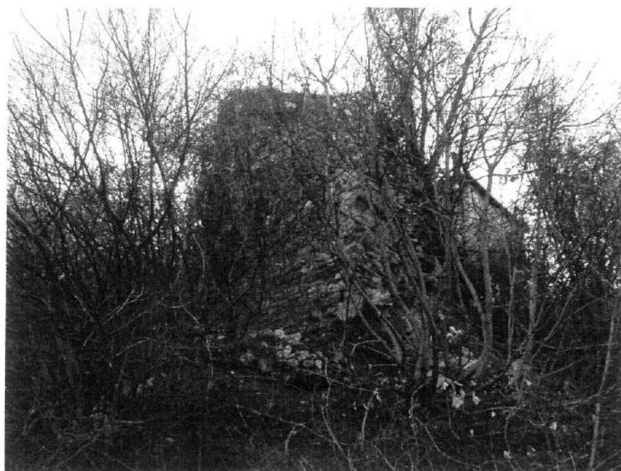
7. Torrione nei pressi della part. 225
