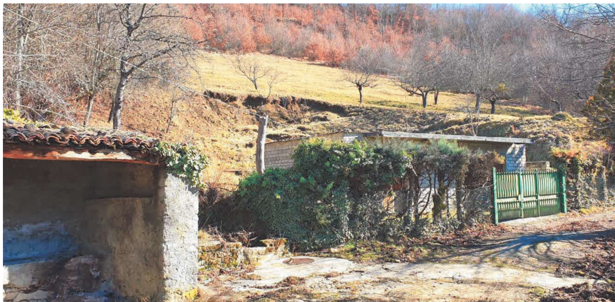
Vista frontale della zona di intervento
