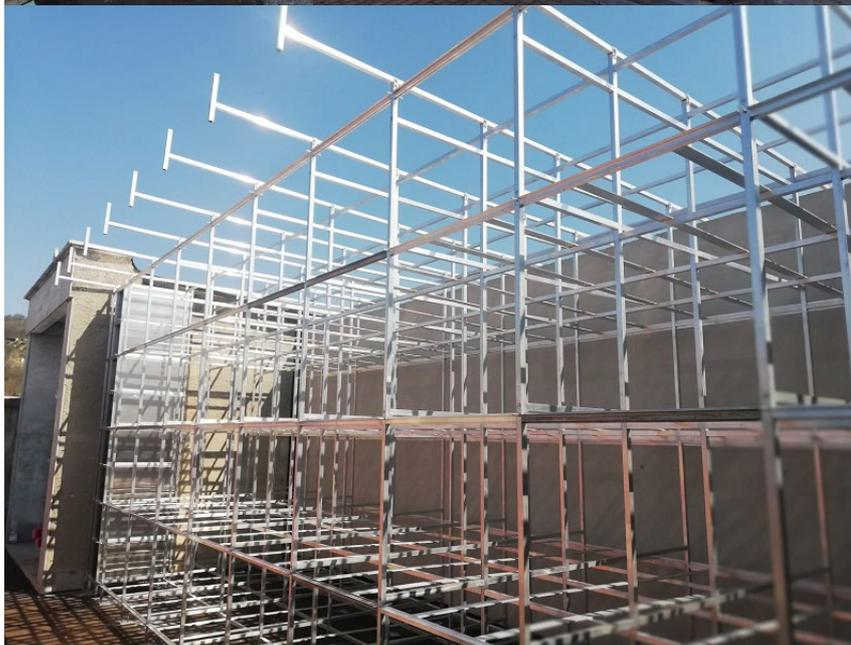
santi da 8 MA 8.8, con regolazione in altezza eseguita mediante piastre di supporto poste alla base, traversi anteriori dei ripiani realizzati con un profilo speciale costituito da un tubolare mm. 25x25x2 dotati di lama sporgente per mm. 15 atte al sostegno e all'allineamento della lapide; -
