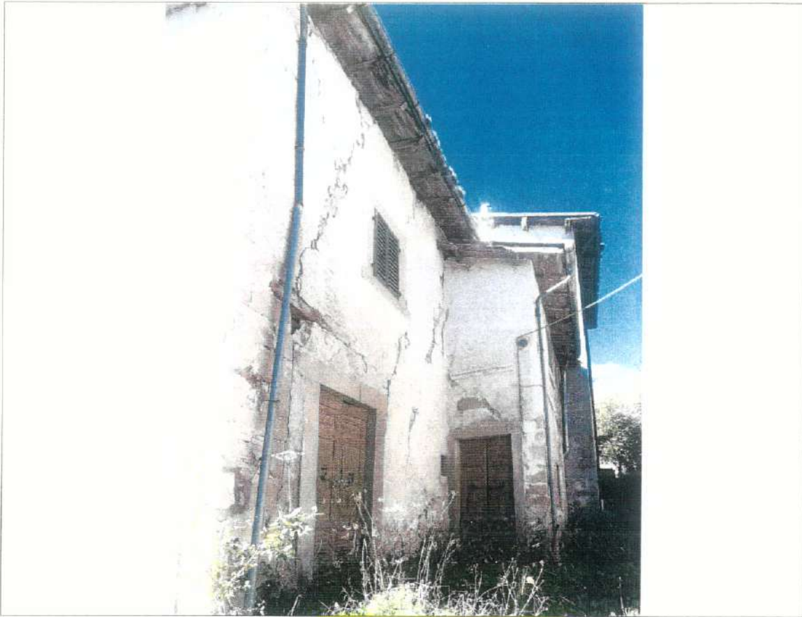
FOTO -4- (P.lla 125 sub. 1)
