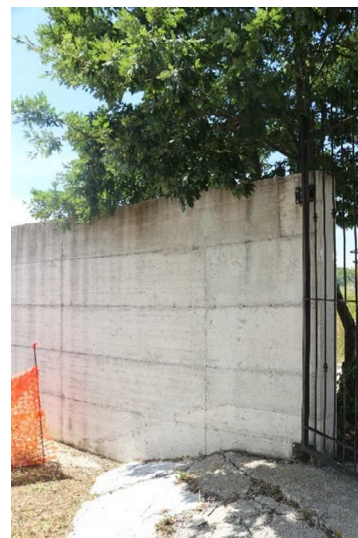
Figura 8 - Porzione di muro perimetrale in c.a. a vista
