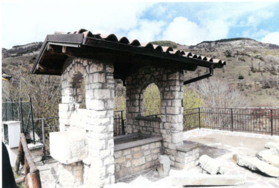
FOTO -2- (P.la lavatoio/fontana fronte p.la 26)
