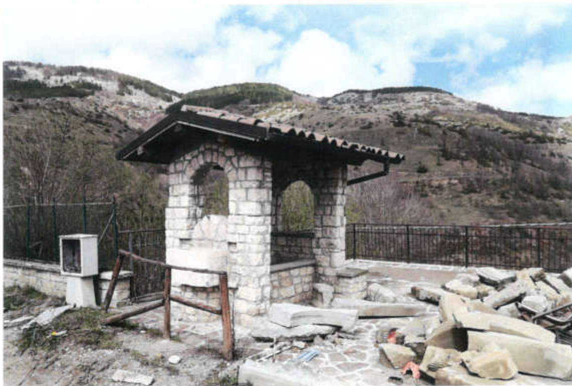
FOTO -1- (P.la lavatoio/fontana fronte p.la 26)
