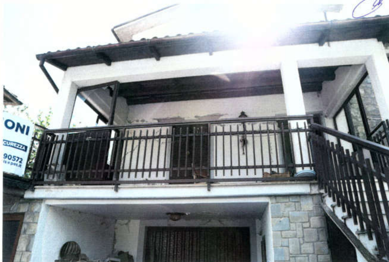
FOTO -1- (P.lla 218 e 225 sub1)
