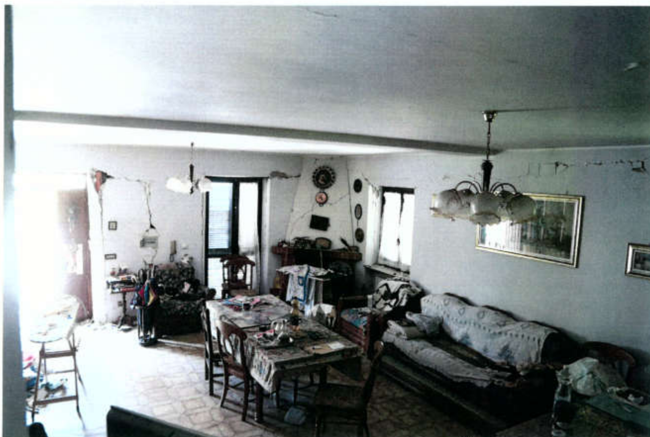
FOTO -2- (P.lla 218 e 225 sub1)
