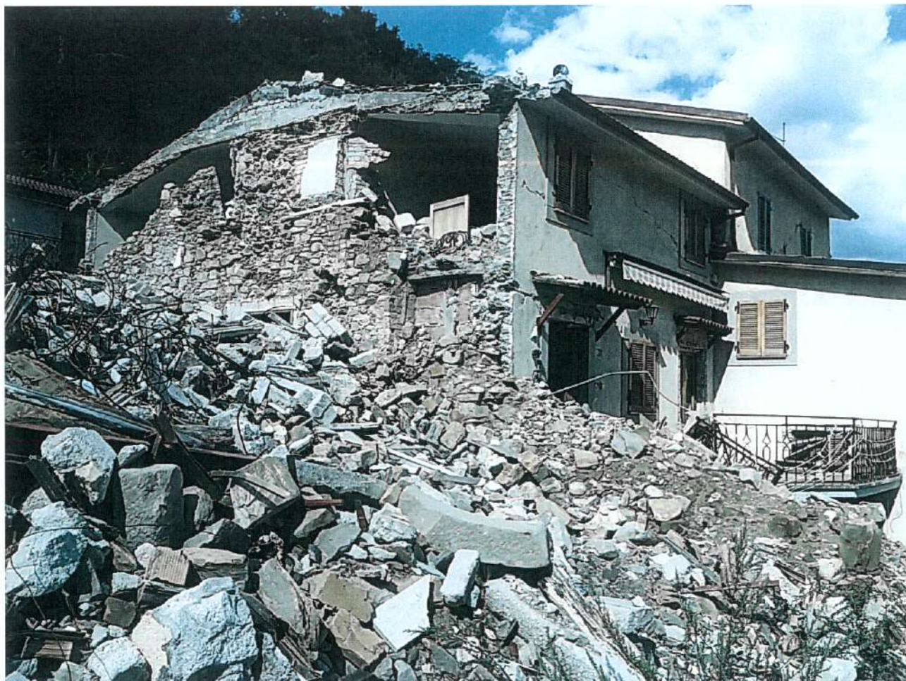
Muro tra le parti demolite e le parti da demolire
