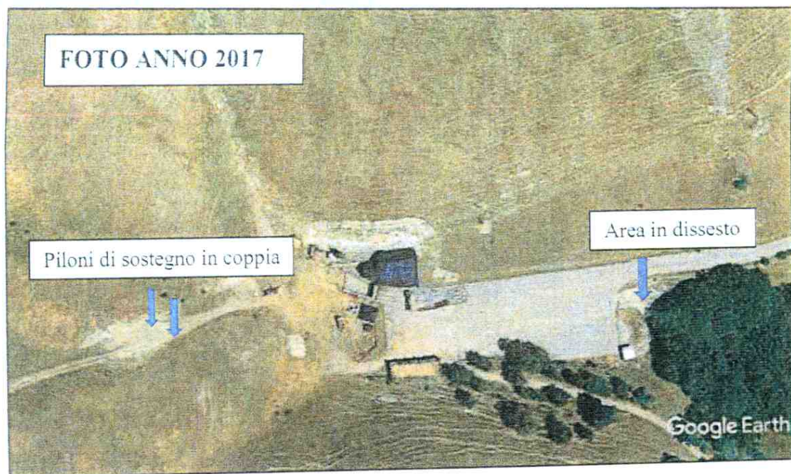
Piazzale antistante la stazione sciistica di Selva Rotonda - data 26/06/2017
