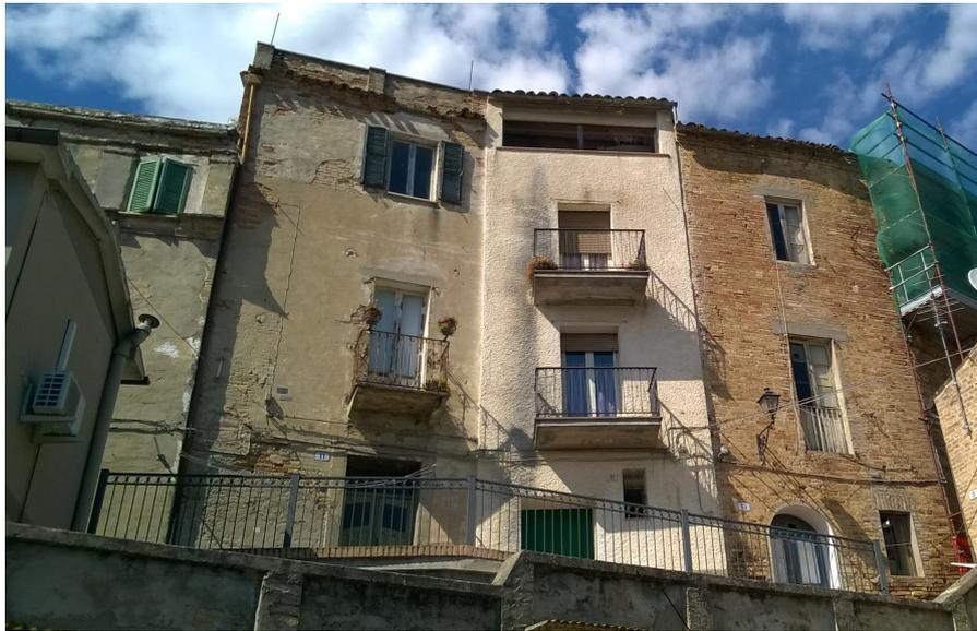
*Esempio di vulnerabilità di murature perimetrali adiacenti non collegate e di diverso materiale.*
