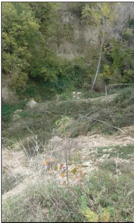
Foto n. 8 - Accumolo di frana che sbarra il corso del fosso sottostante.
