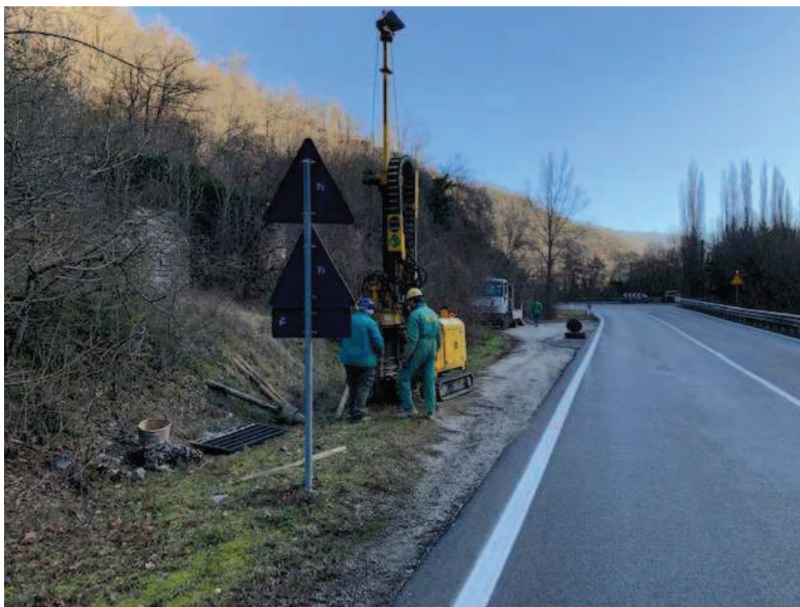
POSTAZIONE SONDAGGIO S1
