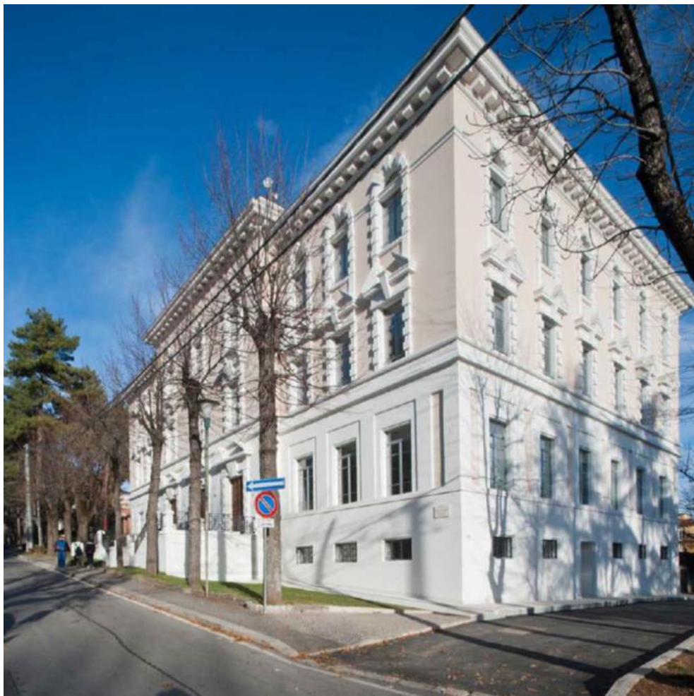
Palazzo Ex-Giovane Italia a L'Aquila sede del Consiglio Regionale dell'Abruzzo – ora sede della Gran Sasso Science Institute – edificio adeguato sismicamente mediante l'isolamento alla base
