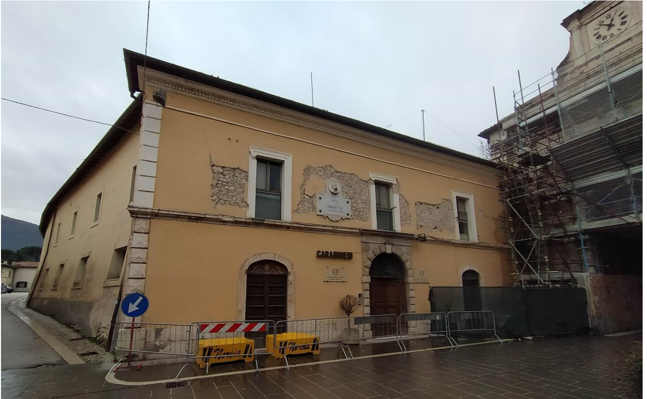
Prospetto su Corso Sertorio
