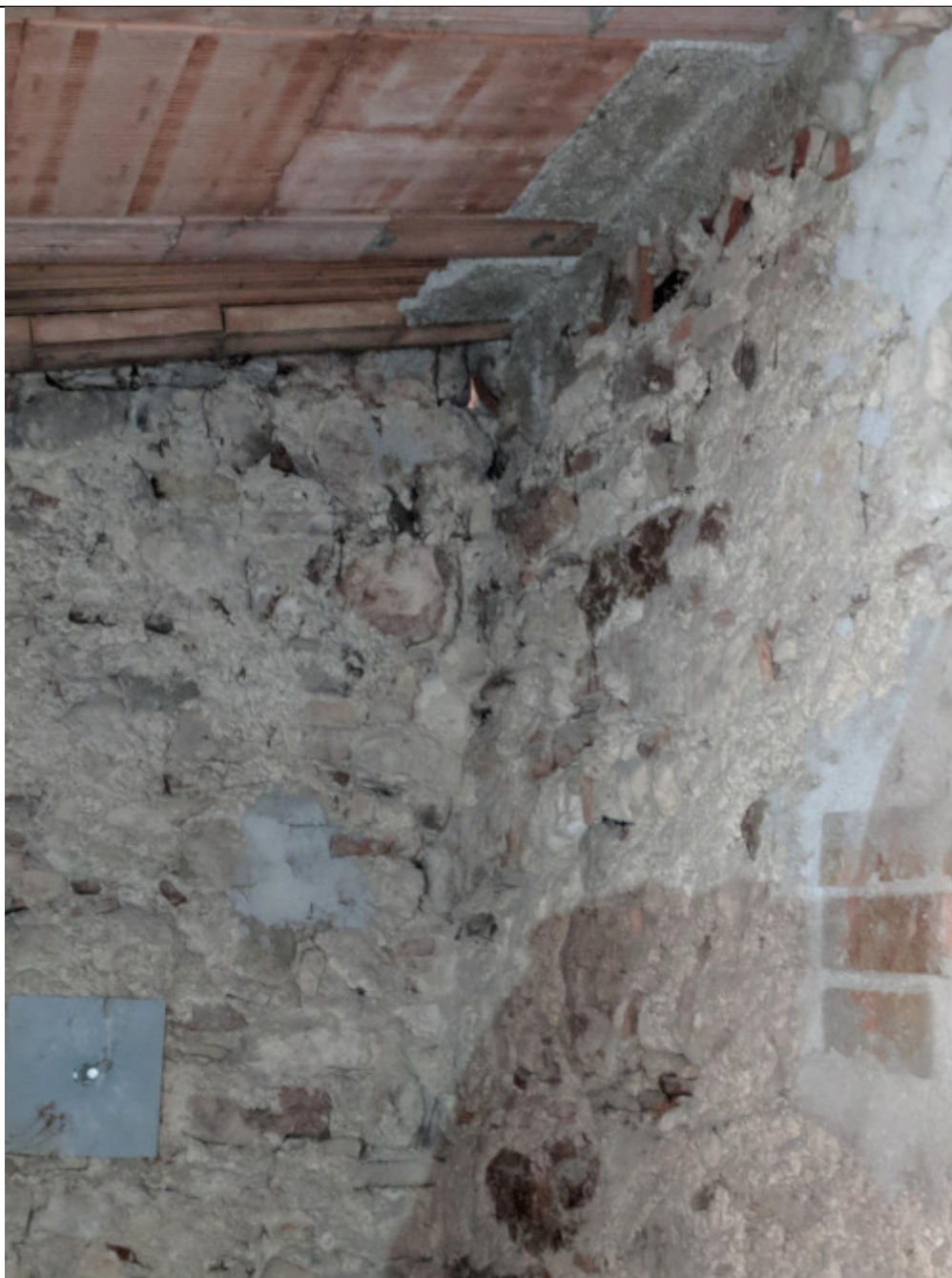
Foto 44 (lesione danno grave ampiezza >0,5mm)
