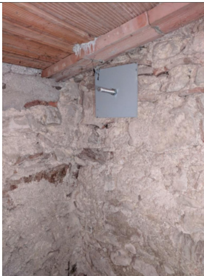
Foto 43 (tiranti messa in sicurezza)
